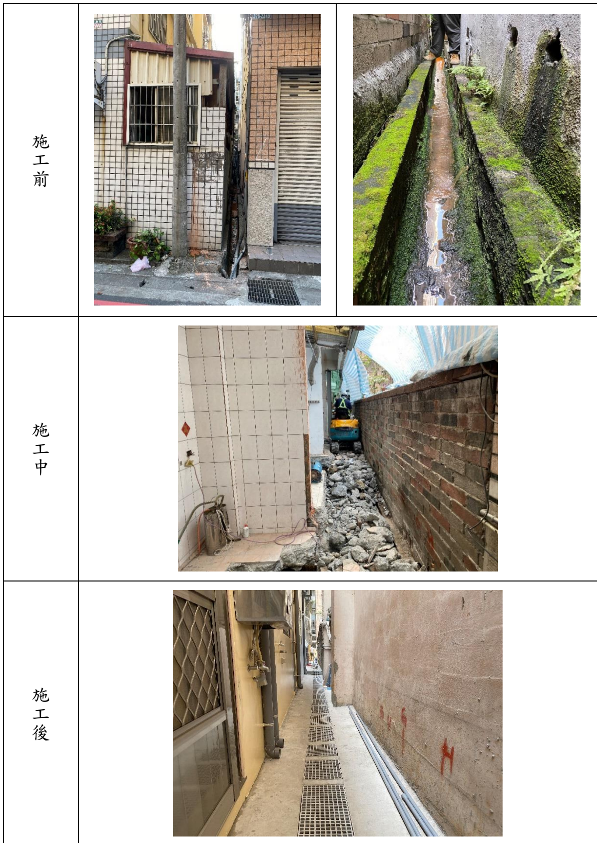
圖 9 工業區一路政府施工前、後案例照片
