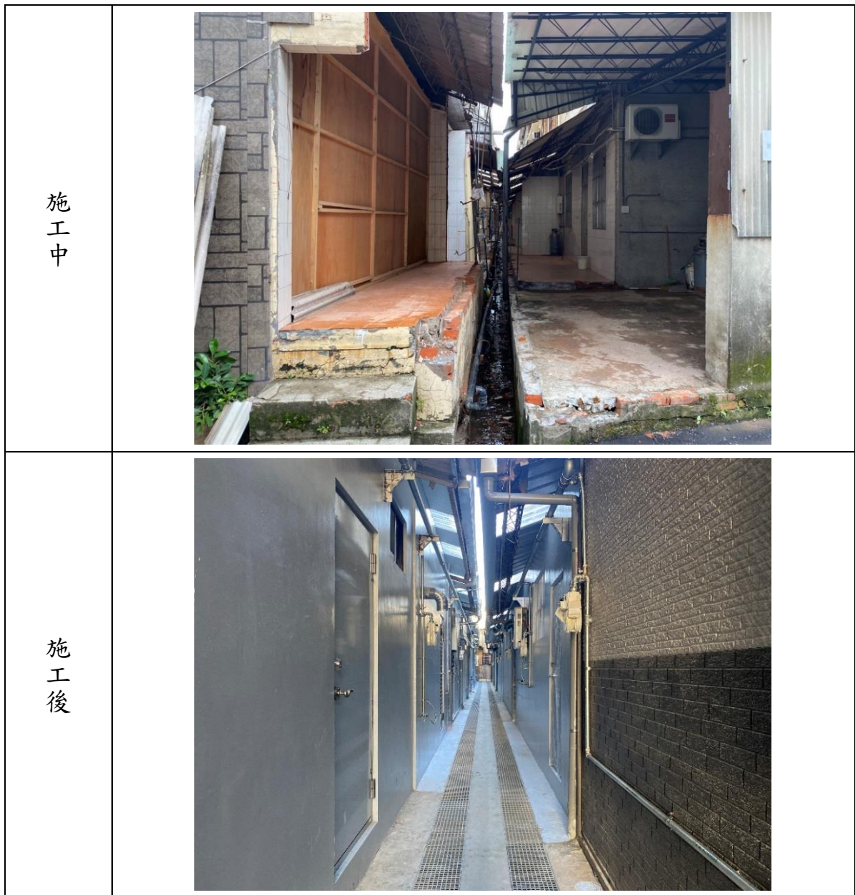
圖 8 豐原區豐南街政府施工前、後案例照片
