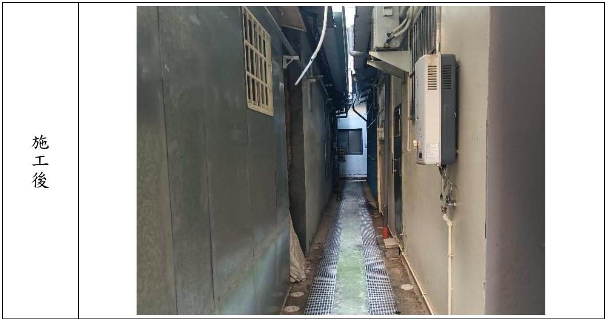
圖 7 西區昇平街政府施工前、後案例照片
