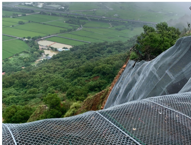
圖 9 北側邊坡整治完工圖
