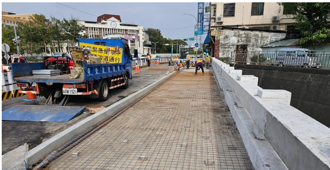
忠明南路施工情形
