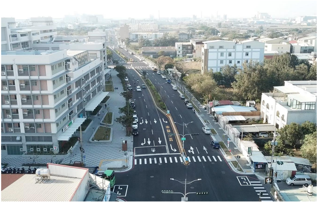
文化路一段與建國北街交叉路口
