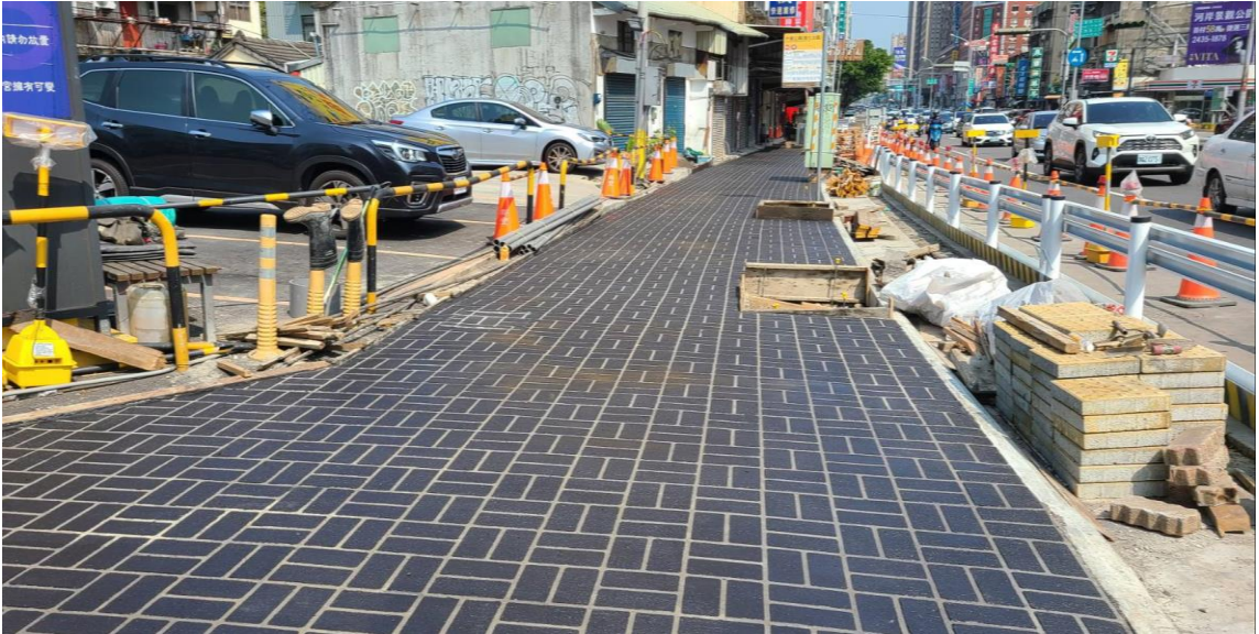
進化北路施工情形
