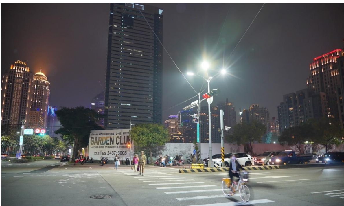
臺灣大道分隔島設置 4 臂燈桿
