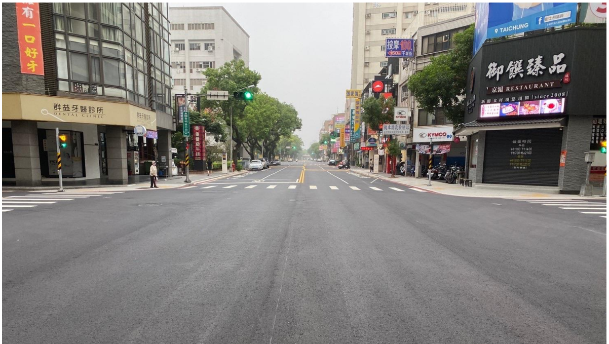
黎明路二段燙平完成
