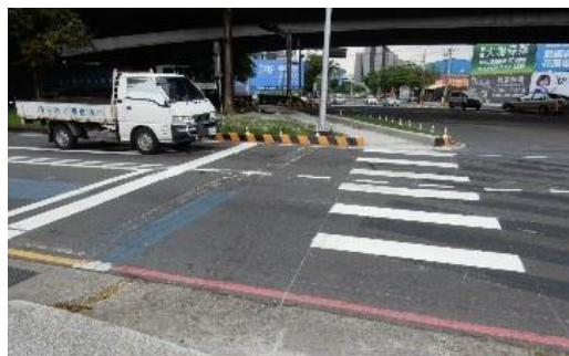
南屯區環中路口
