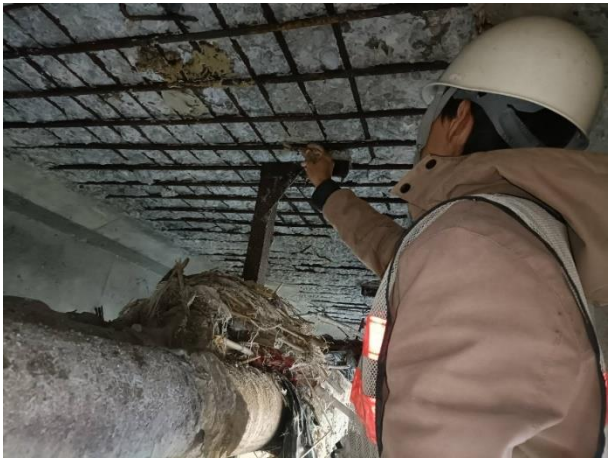
橋面板混凝土剝落鋼筋外露修復
