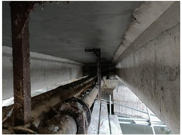
橋面板混凝土剝落鋼筋外露修復
