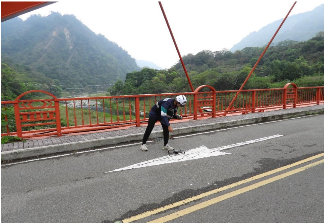
使用UAV協助進行下部結構現況拍攝
