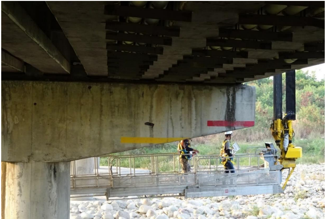
檢測人員使用橋檢車進行下部結構檢查
