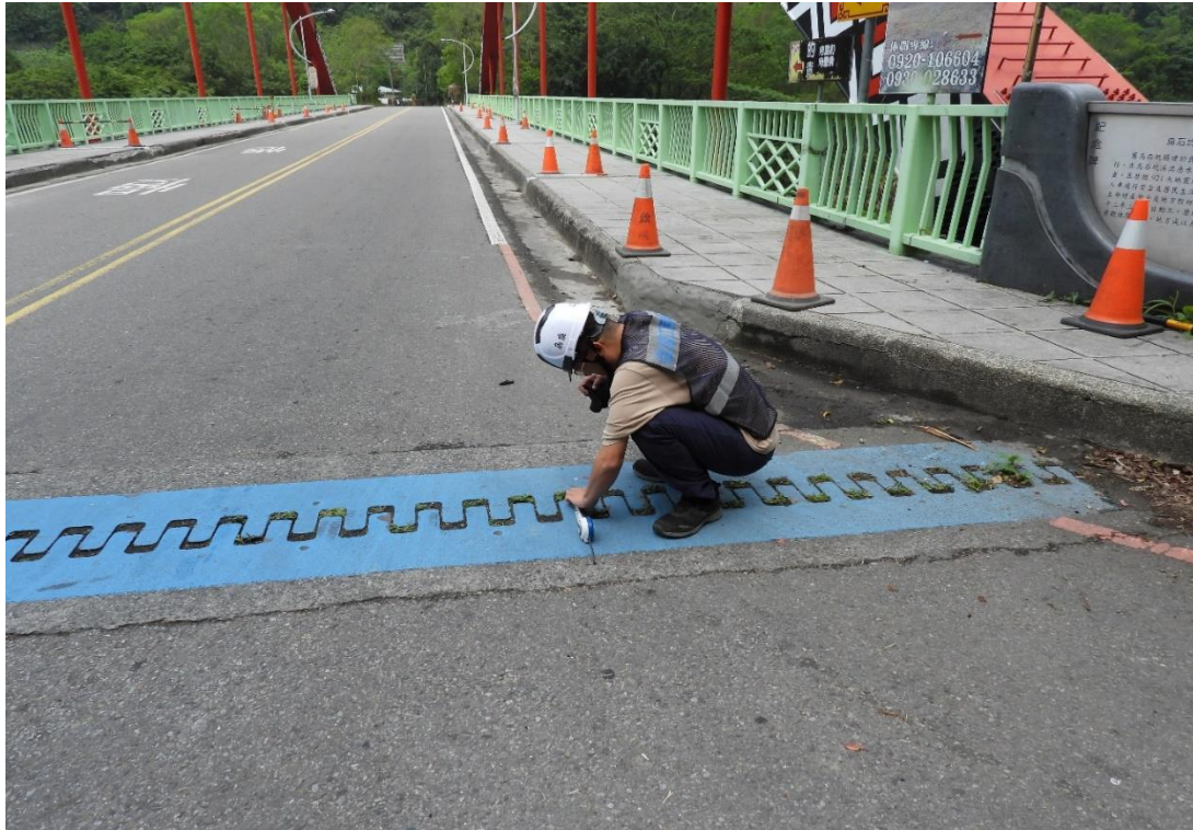
檢測人員進行伸縮縫間隙量測
