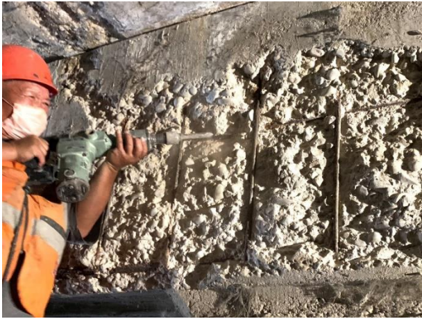
橋墩混凝土剝落鋼筋外露修復
