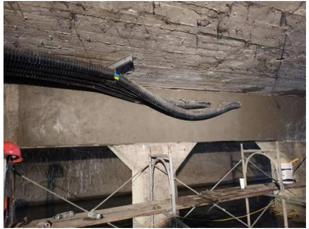
橋墩混凝土剝落鋼筋外露修復
