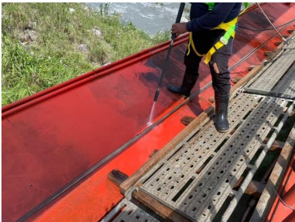
鋼拱橋外露面清洗
