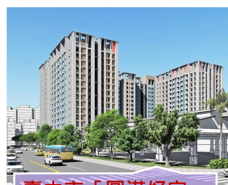
臺中市「圓滿好宅」 社會住宅工程
