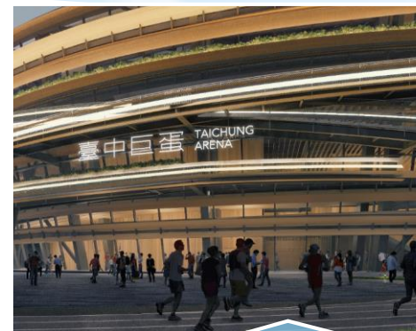
臺中市巨蛋體育館 興建工程
