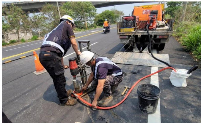
鑽心取樣〈AC厚度、 壓實度、壓密度、含油量〉
