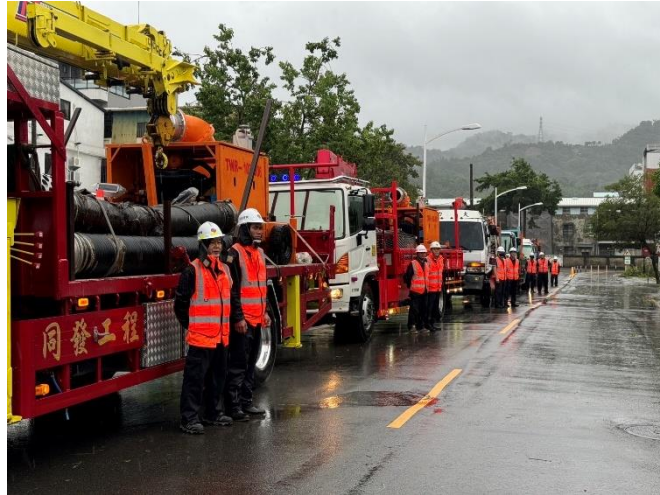
水利局支援抽水機組整備情形
