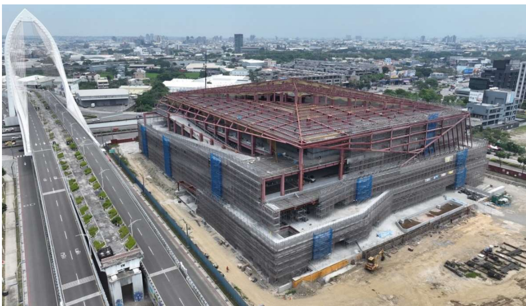
圖 15 水湳轉運中心新建工程施工近照
