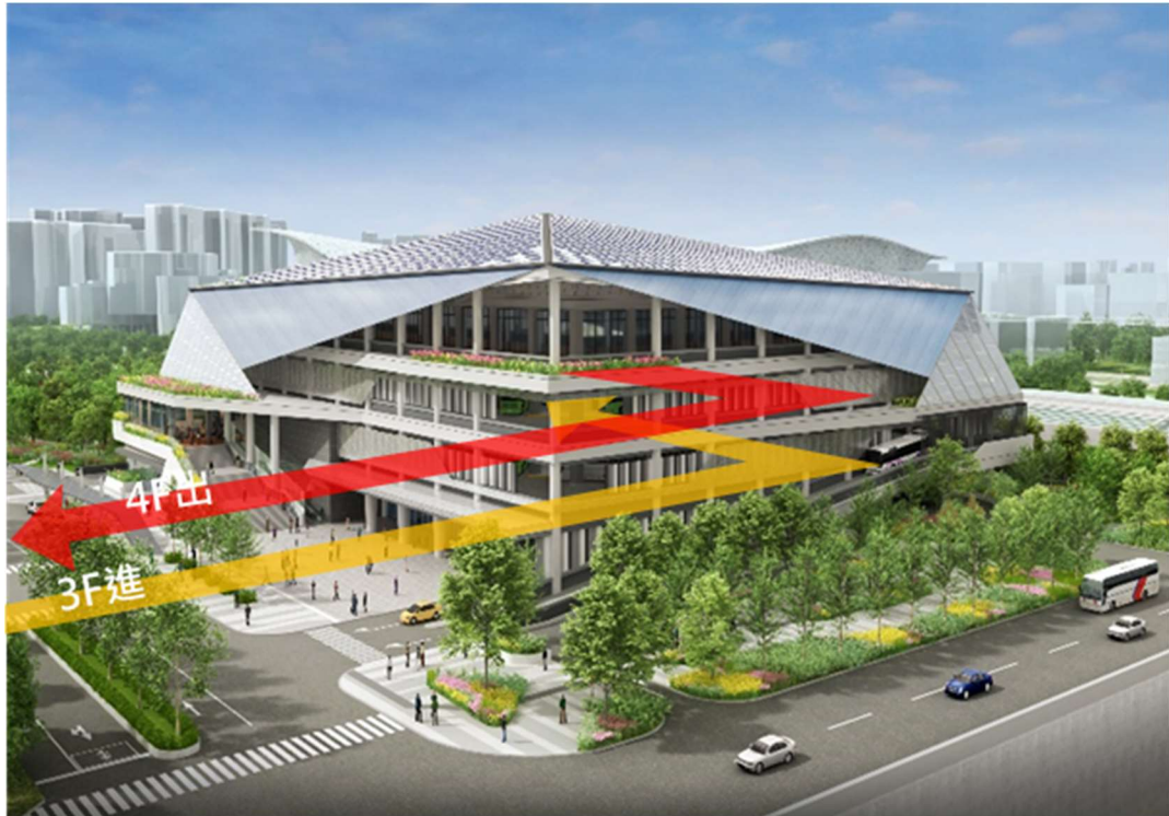
圖 14 水湳轉運中心國道客運專用道銜接示意圖(3F 進、4F 出)
