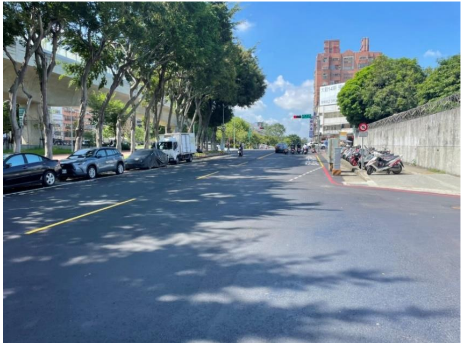
東區南京東路一段雨水下水道工程-完工照片
