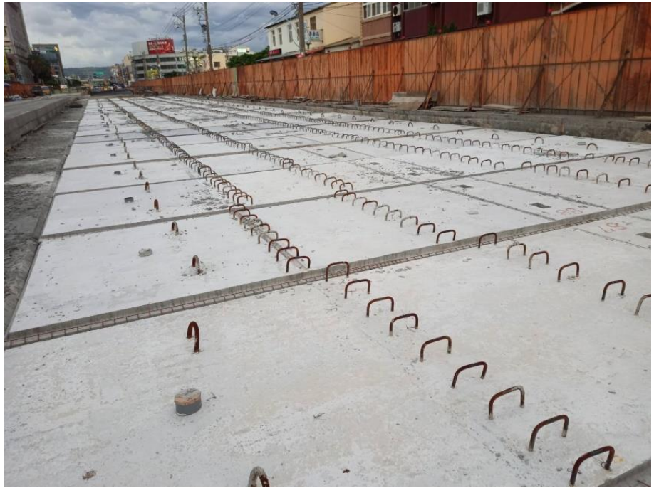
梧棲區大智路二段雨水下水道後續改善工程-施工中照片
