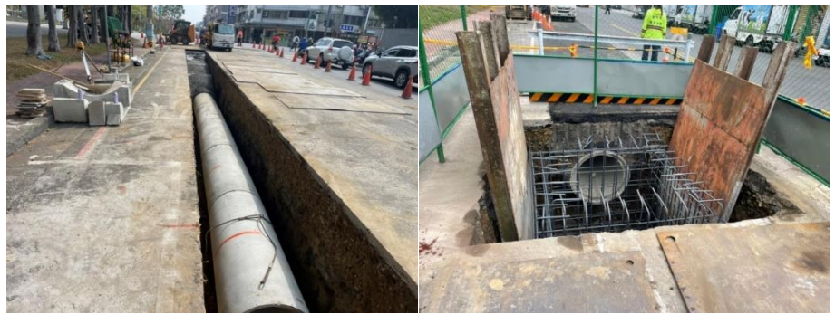
東區南京東路一段雨水下水道工程-施工中照片
