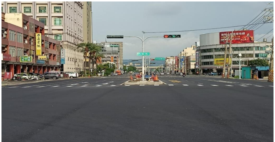
梧棲區大智路二段與八德路口開放通車
