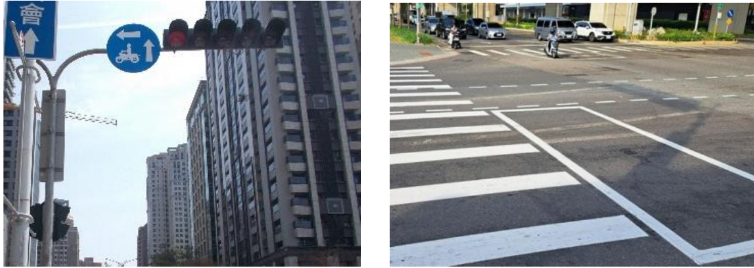
圖四：機慢車兩段式左轉標誌及待轉區(左：西屯區市政北一路與惠中路口、右：太平區中山路與環中東路口)
