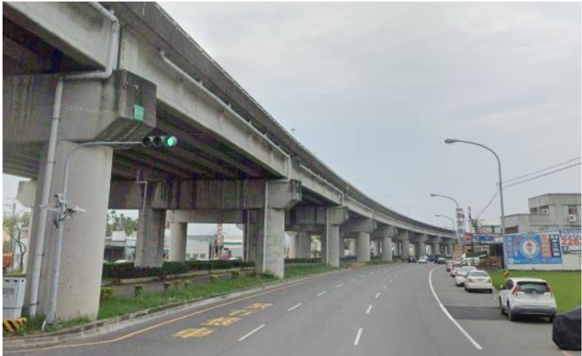
圖 5 中投東路二段(國道 3 號中投交流道至峰堤路，往北方向)
