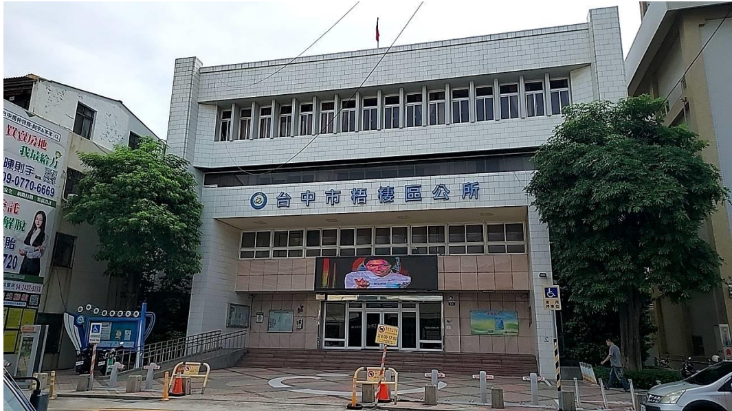
圖三：梧棲區公所行政大樓外觀
