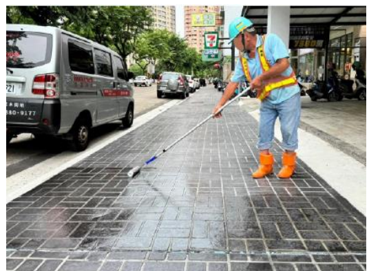
人行道鋪面塗抹保護漆，增加耐磨耐候。
