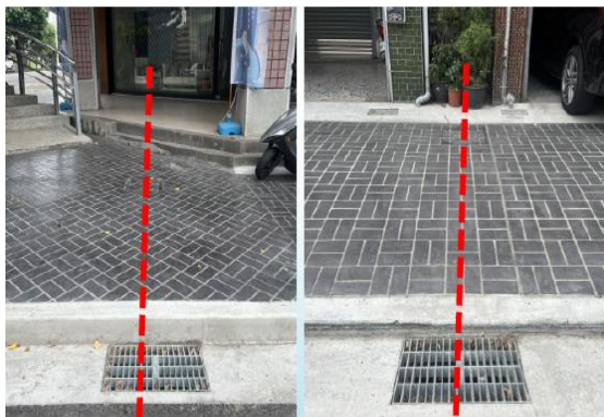
排水溝蓋口避免設置在住家門口。
