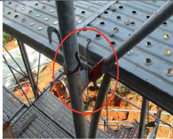
施工架以連結器連結避免倒塌。
