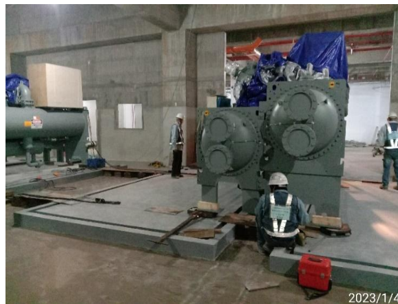
牆面緩築供冰水主機進場安裝
