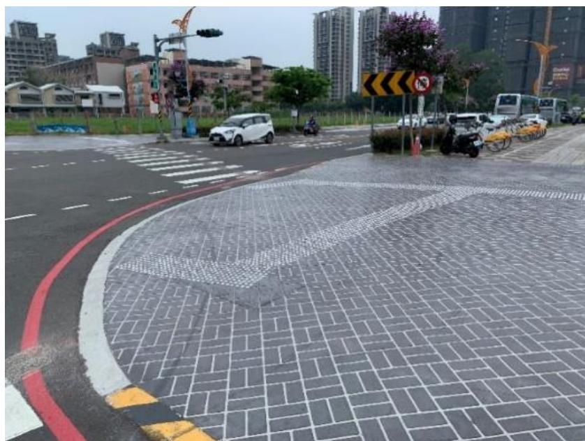
圖 13 人行道兩側增設無障礙斜坡道
