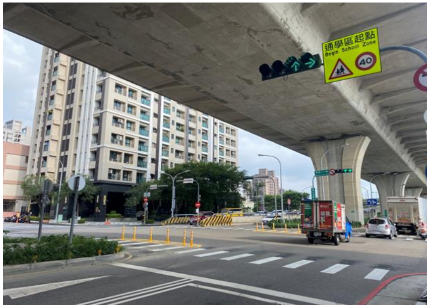
圖 6 設置通學區牌面(限速標誌 40)、標線型庇護島頭
