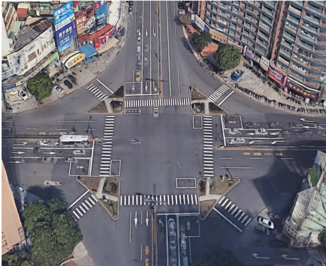
圖 41 進化北路人本改善工程改善前
