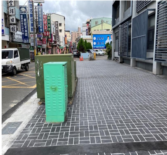
圖 16 電箱遷移後人行道通行淨寬大於 1.5 公尺
