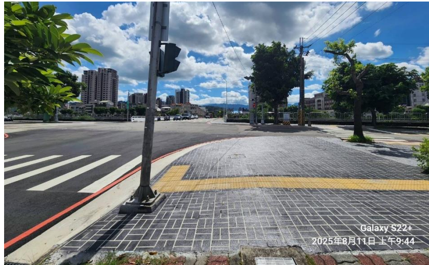
圖 12 人行道兩側增設無障礙斜坡道
