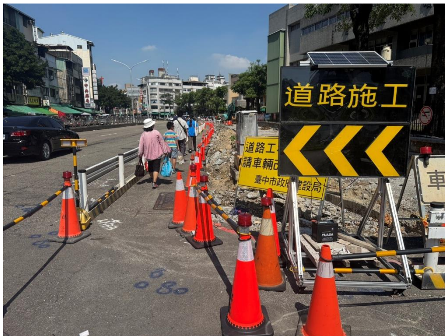
圖 23 人行道工程-設置臨時行人通道，維護行人安全
