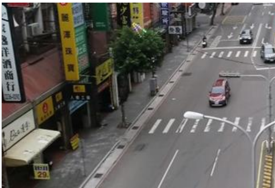
圖 43 進化北路人本改善工程改善前
