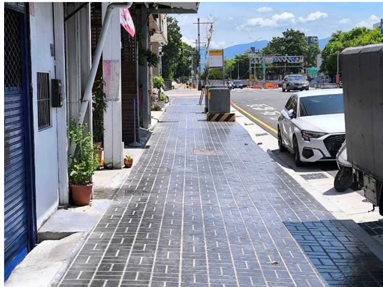
圖 17 電箱遷移後人行道通行淨寬大於 1.5 公尺
