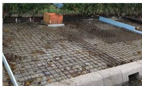
鋪設點焊鋼絲網
