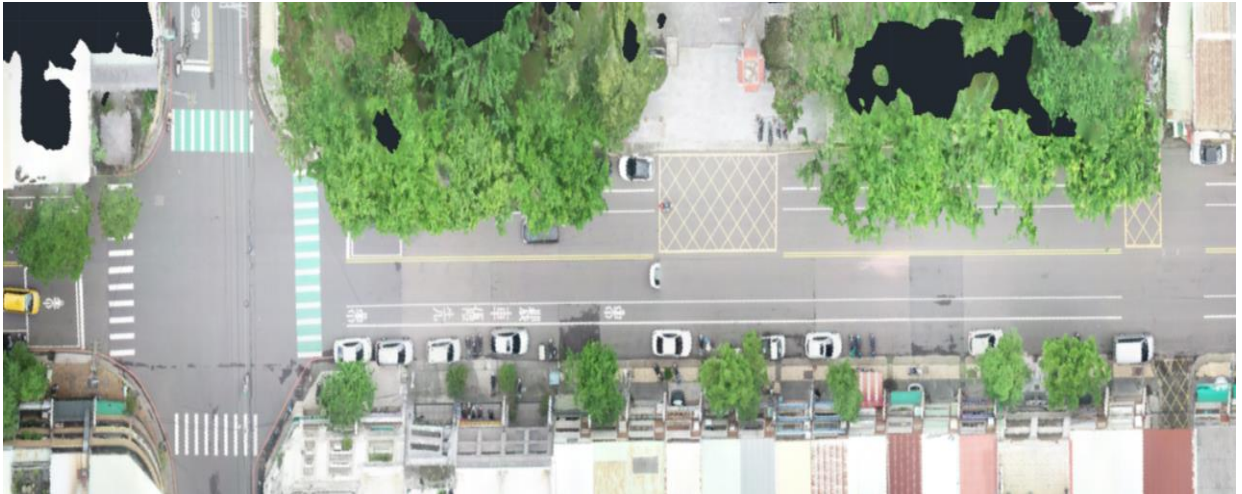
圖 33 中興東路人本改善工程改善前
