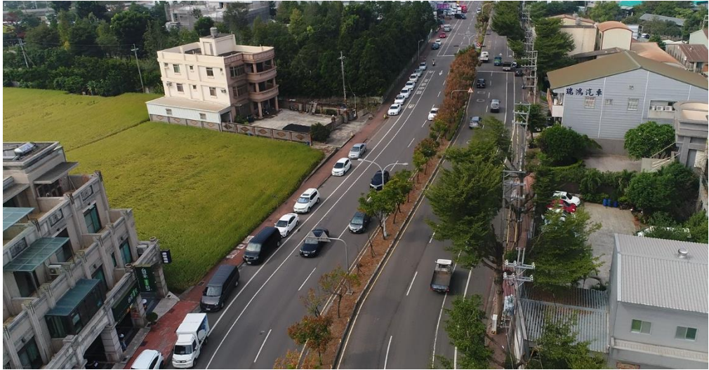
圖 25 雅潭路三段人本改善工程改善前
