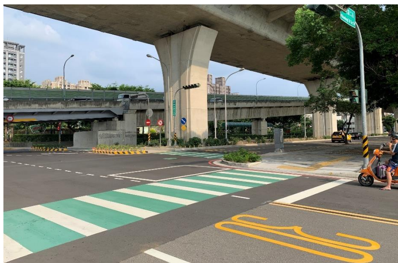
圖 7 設置通學區牌面(30)、限速標字(30)、視覺化減速標線
