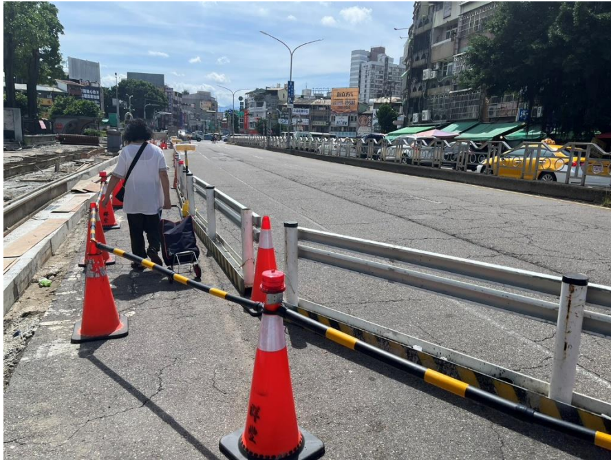
圖 22 人行道工程-設置臨時行人通道，維護行人安全
