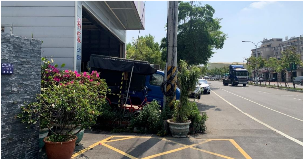
圖 27 雅潭路三段人本改善工程改善前-私人物品佔用、無通行空間
