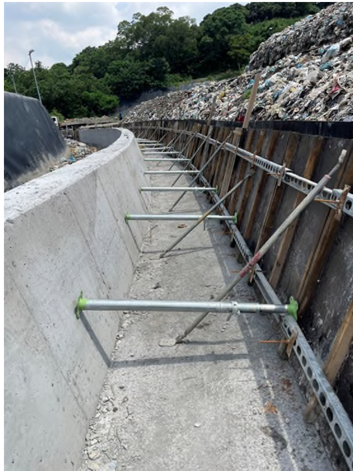
圖 7、污水收集改善工程(進行中)
