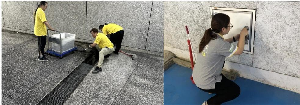
圖 54：汙水、雨水、廢水集水池抽水馬達運轉測試
