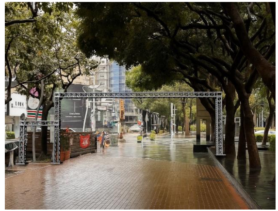
圖 18：服務臺電力使用市民廣場電箱，將電線以 truss 架高，以維護民眾安全。
