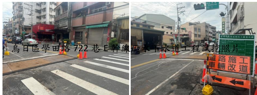
烏日區學田路 722 巷 E 幹線雨水下水道工程施工試挖照片
