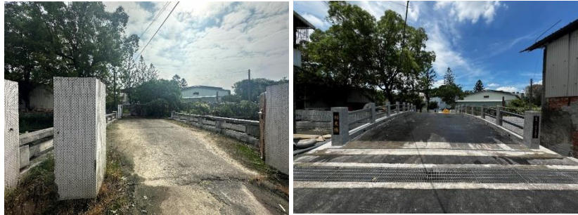
車籠埤排水利農橋施工前(左)、後(右)
