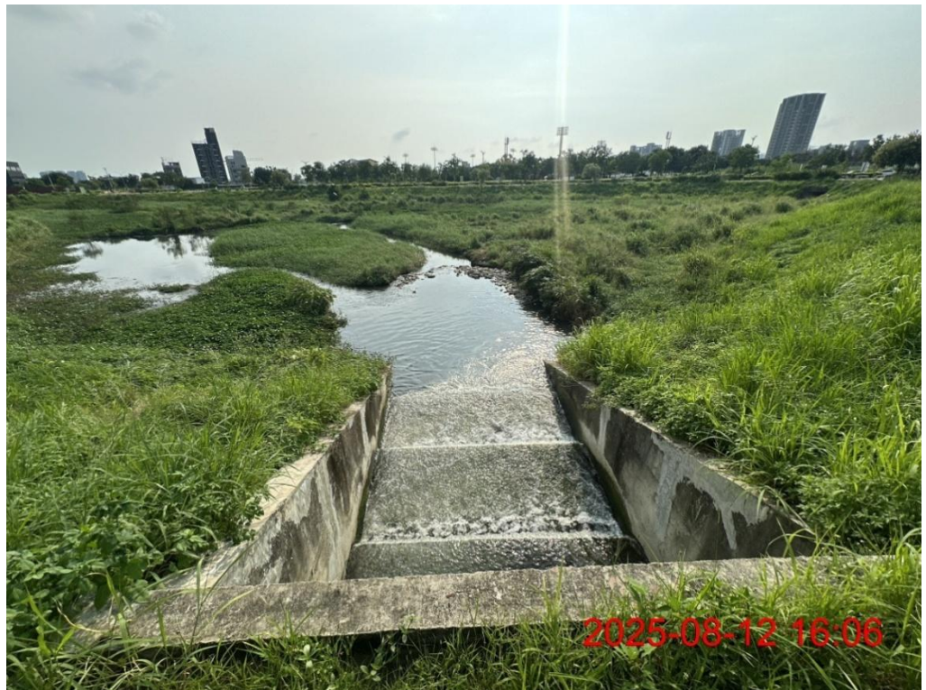
圖 12、臺中市新八自辦市地重劃區公 95 滯洪池現況照片
