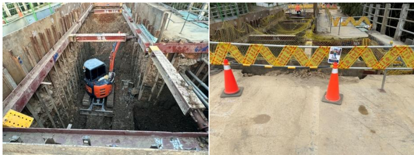
沙鹿區福至路(L11)雨水下水道工程施工中照片
