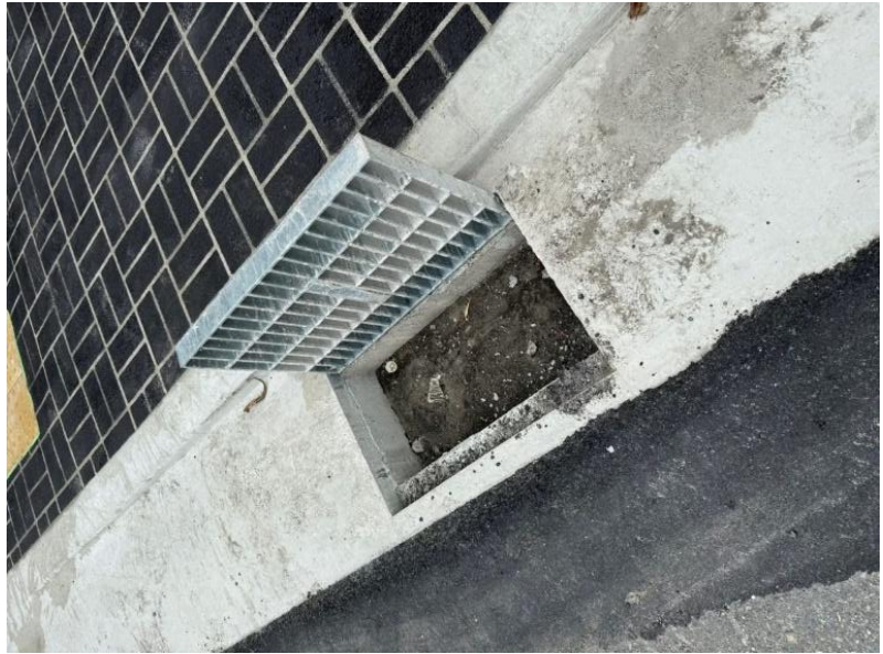
圖、尚未施工完成之側溝
