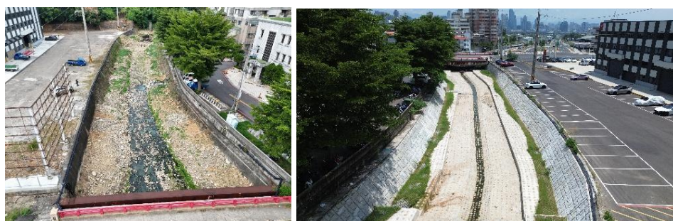
東大溪工業一路上游改善工程施工前(左)、後(右)
