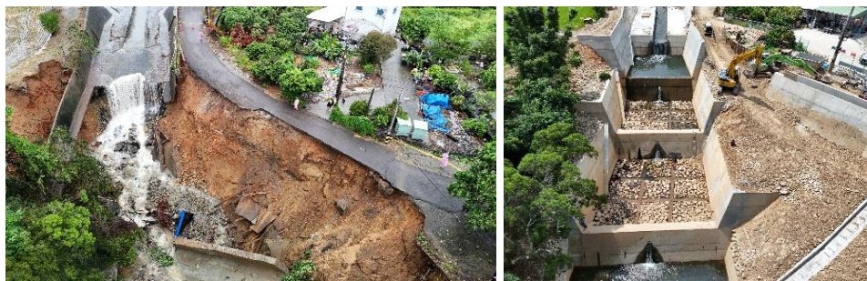
陽明山排水護岸改善治理工程前(左)、中(右)
