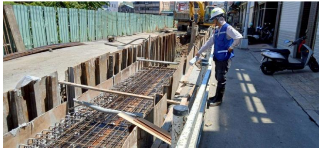
沙鹿區永寧路 208 巷下水道改善暨南陽路雨水下水道工程施工中照片
