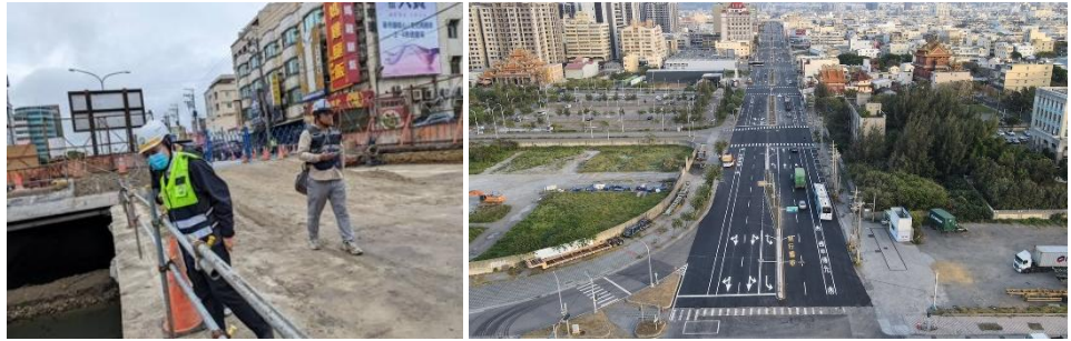
梧棲區大智路二段雨水下水道後續改善工程施工中(左)、完工空拍(右)
