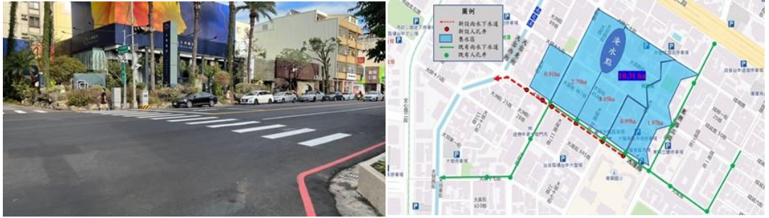
西屯區大隆路雨水下水道工程完工後(左-大榮東街-大墩路口)、工程範圍圖(右)
