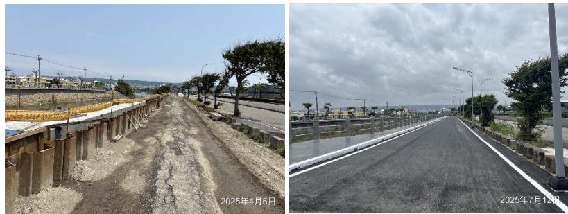
梧棲區安良港排水(永天橋下游段)應急工程施工中(左)、後(右)
