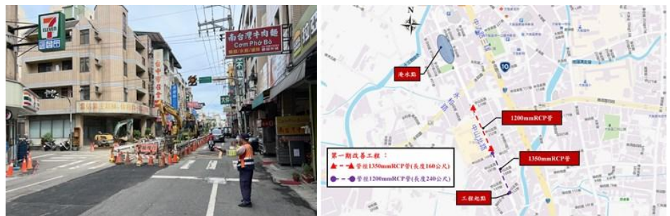
大雅區中山北路雨水下水道新建暨改建工程施工中(左)、工程範圍圖(右)
