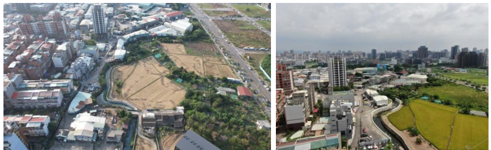
潭子區龍形溝圳路強化工程施工前(左)、後(右)
