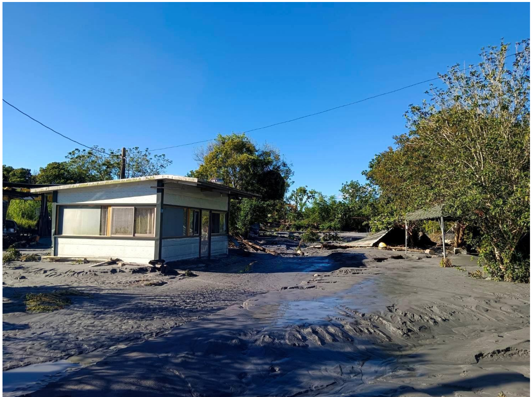
圖12 馬太鞍部落災害現況(本市原住民提供)
