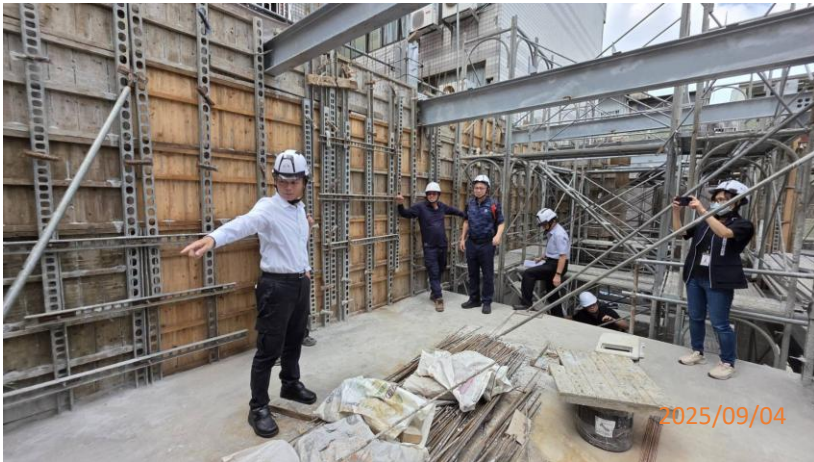
臺中市歷史建築林森路75號日式宿舍 修復工程
