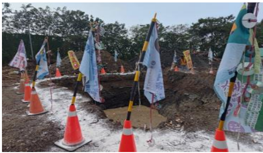
后里及沙鹿垃圾衛生掩埋場設置插旗幟及撒石灰防止動物誤入
