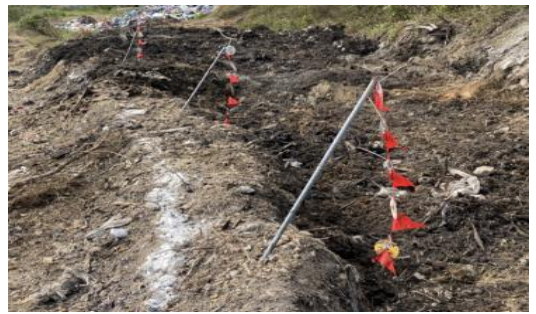
后里及沙鹿垃圾衛生掩埋場設置插旗幟及撒石灰防止動物誤入
