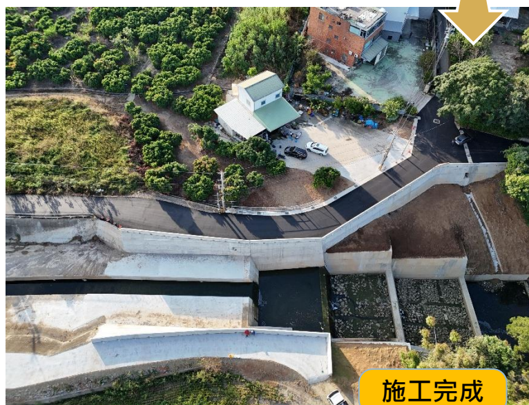
河道跌水工與護岸施工
