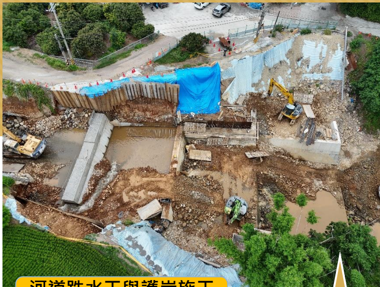
河道跌水工與護岸施工
