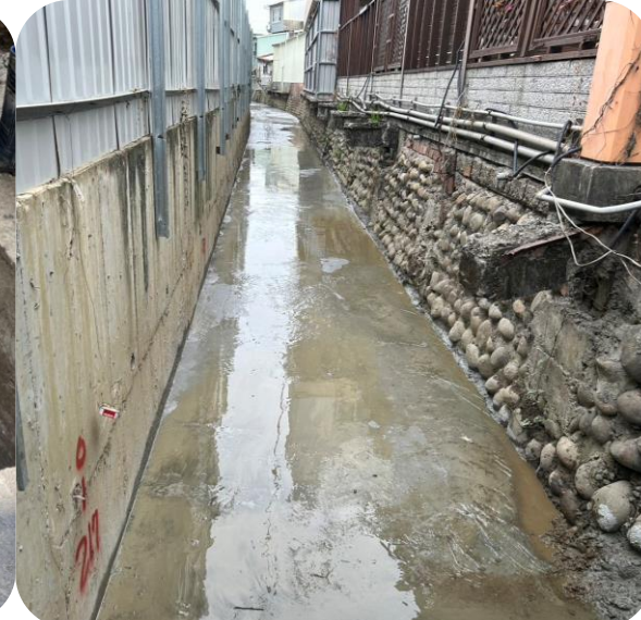
下游排水路設置倒虹吸及渠道封底工程(改善後)
