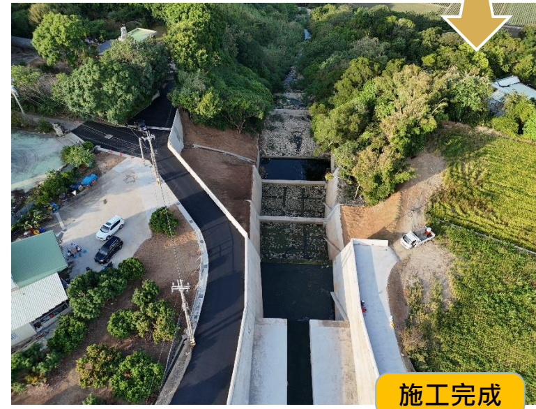
河道跌水工與護岸施工
