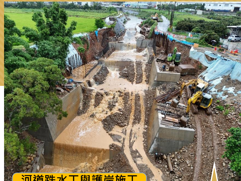
河道跌水工與護岸施工
