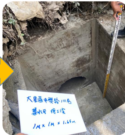
下游排水路設置倒虹吸及渠道封底工程(改善後)
