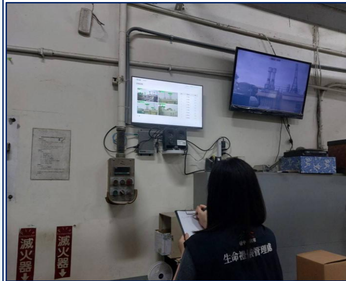
AI 判煙系統火化爐間通報設備
