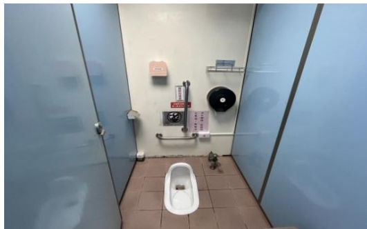
蹲式廁間-安裝扶手
