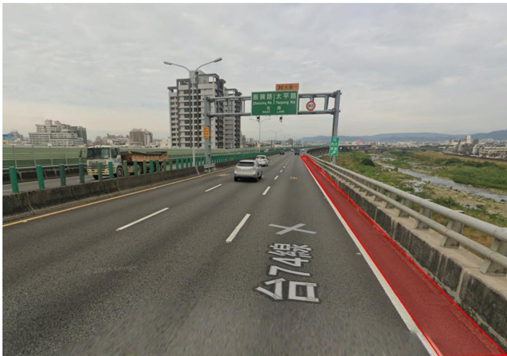
圖 4 部分路段路肩配置空間不足
