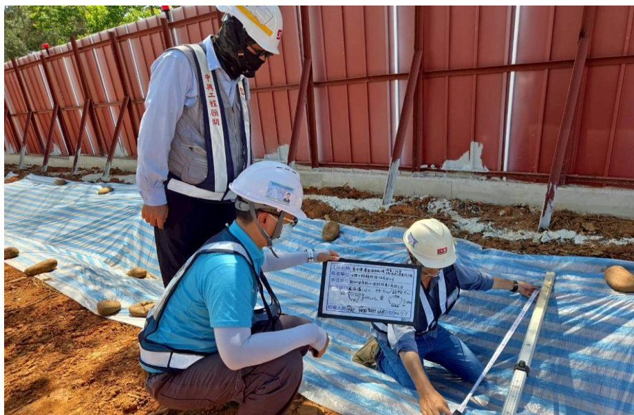
圖 1-4、龍井機廠截流溝施工查驗
