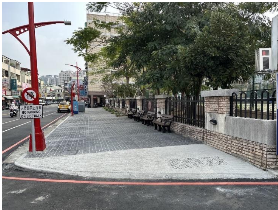
圖 33 東榮路人本改善工程改善後-拆除花台、增設街道家具
