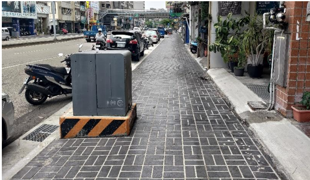
圖 15 電箱遷移後人行道通行淨寬大於 1.5 公尺
