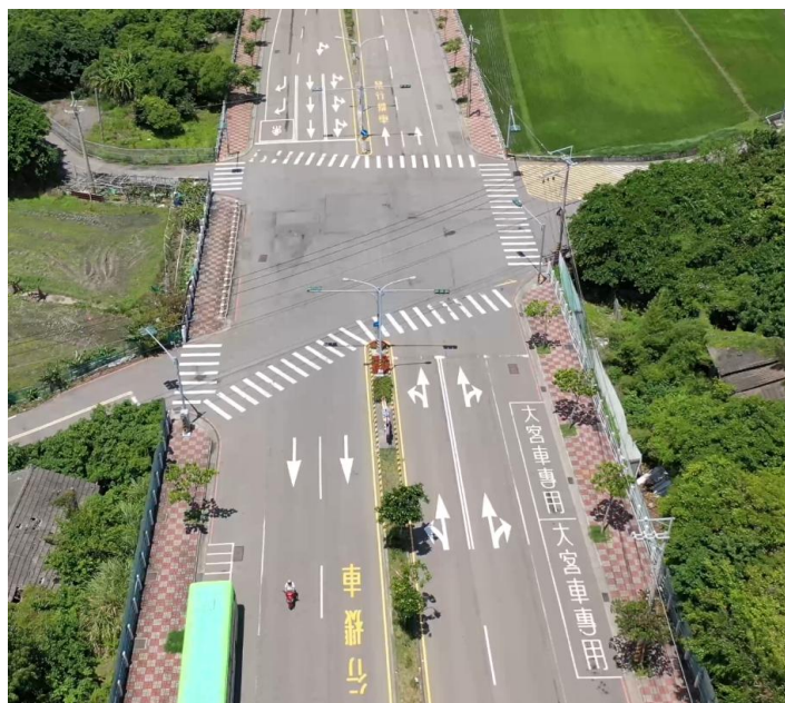
圖 25 鎮政路人本改善工程改善前-五叉路口車輛交織、車道過寬
