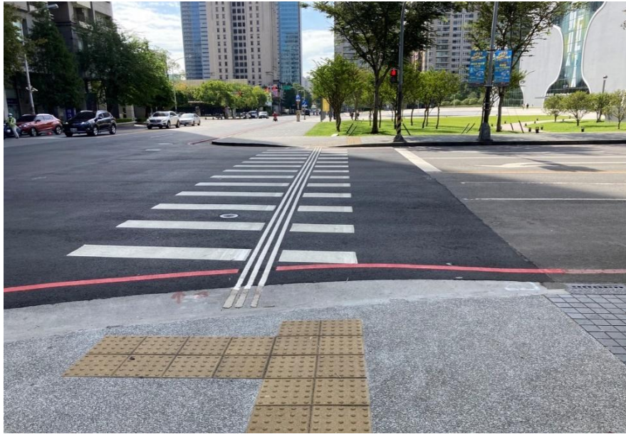
圖 10 人行道兩側設置無障礙斜坡道
