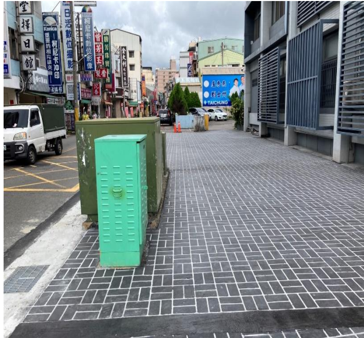
圖 14 電箱遷移後人行道通行淨寬大於 1.5 公尺
