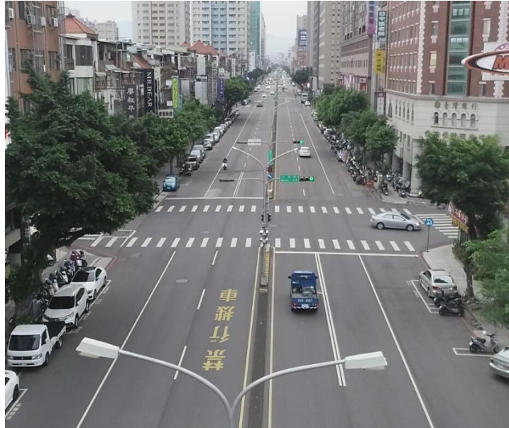
圖 42 進化北路人本改善工程改善前
