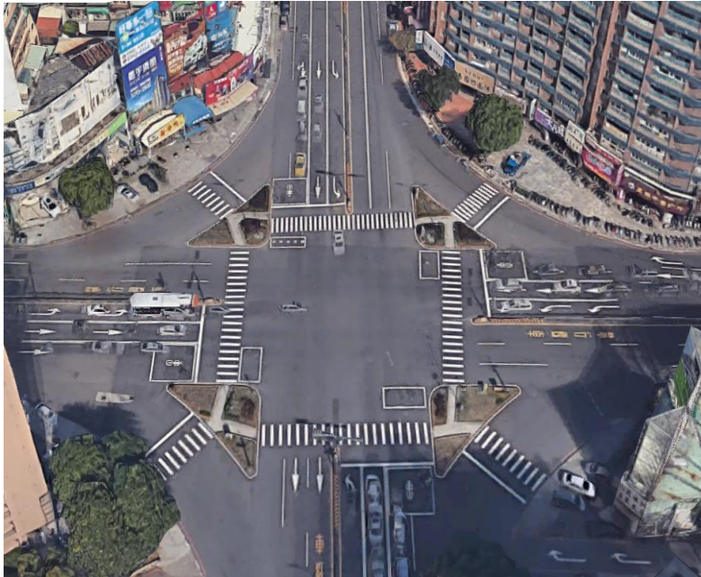
圖 40 進化北路人本改善工程改善前
