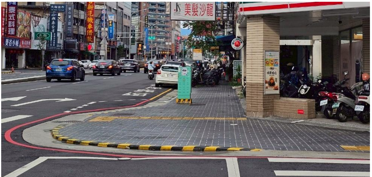
圖 11 人行道兩側設置無障礙斜坡道
