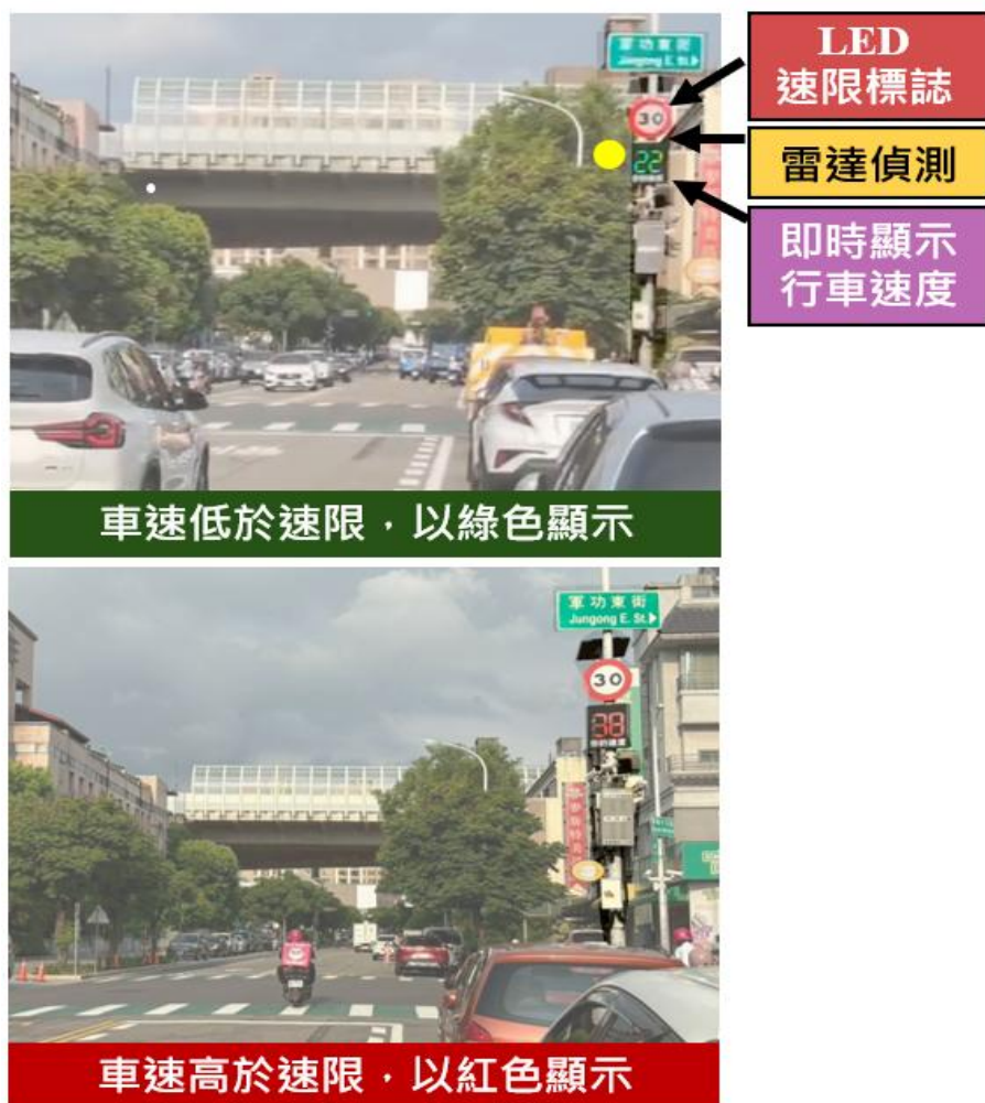
圖 4 車速偵測系統實景運作
