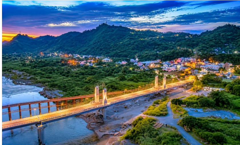
山 東勢埤豐橋夜景(完工)
