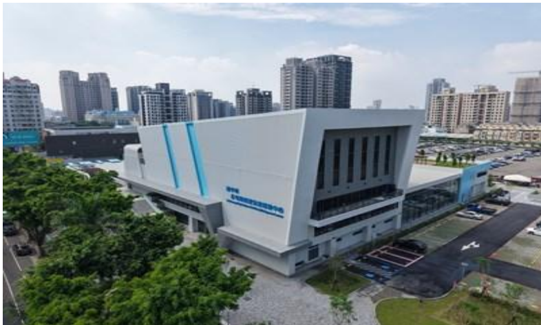
北屯國民暨兒童運動中心(完工)
