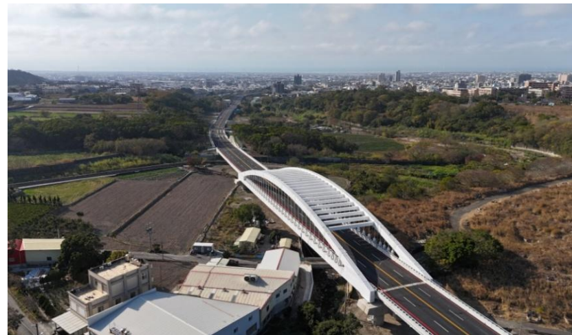
海 甲埔大道1號橋(完工)
