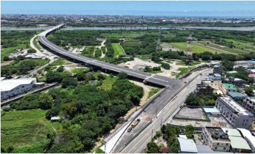
海 大肚和美橋(完工)
