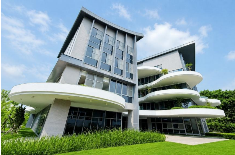
霧峰區聯合行政中心(完工)
