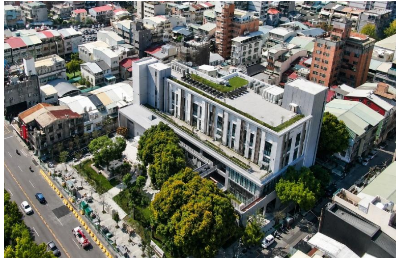
美村綜合服務園區(完工)
