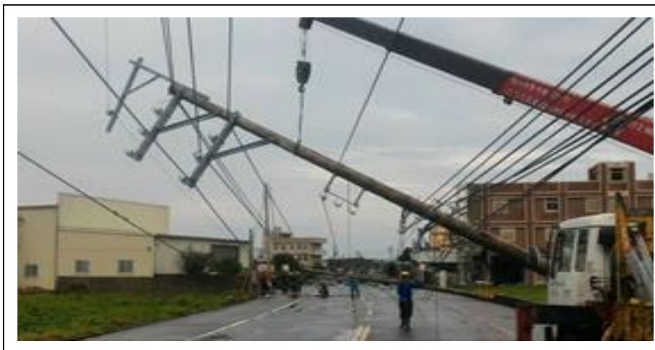
圖 8:臺電搶修照片
