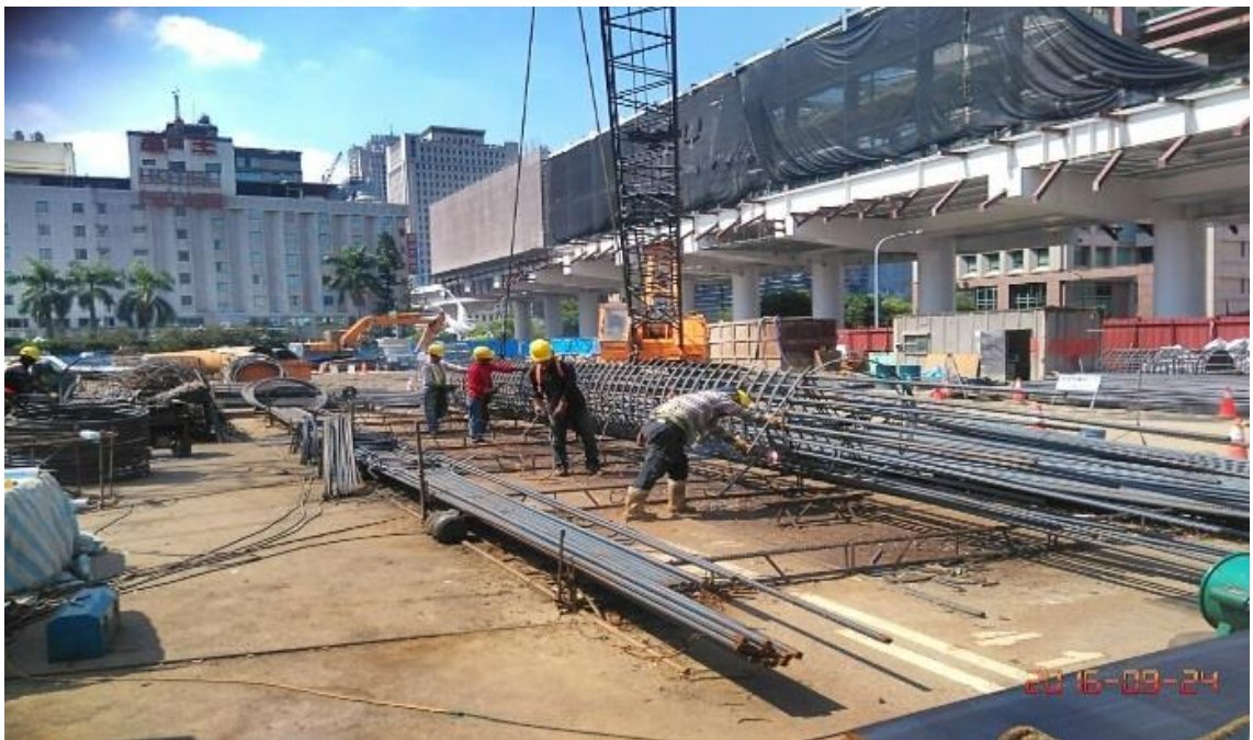
圖 5 共構工程施工現況
