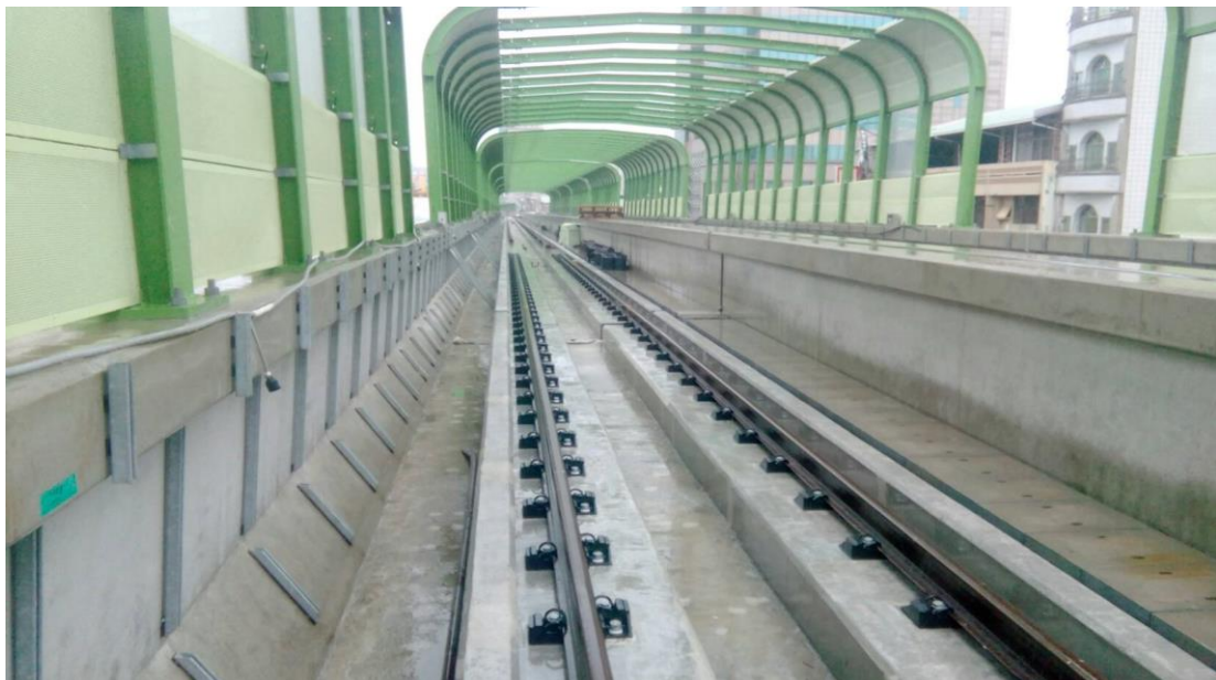
圖 8 路線段軌道完成現況
