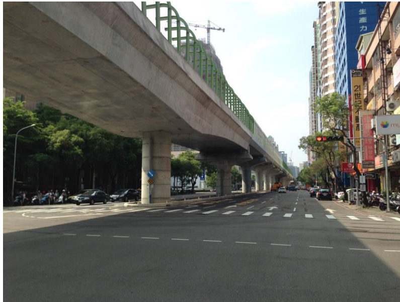
圖 12 捷運沿線施工圍籬拆除現況
