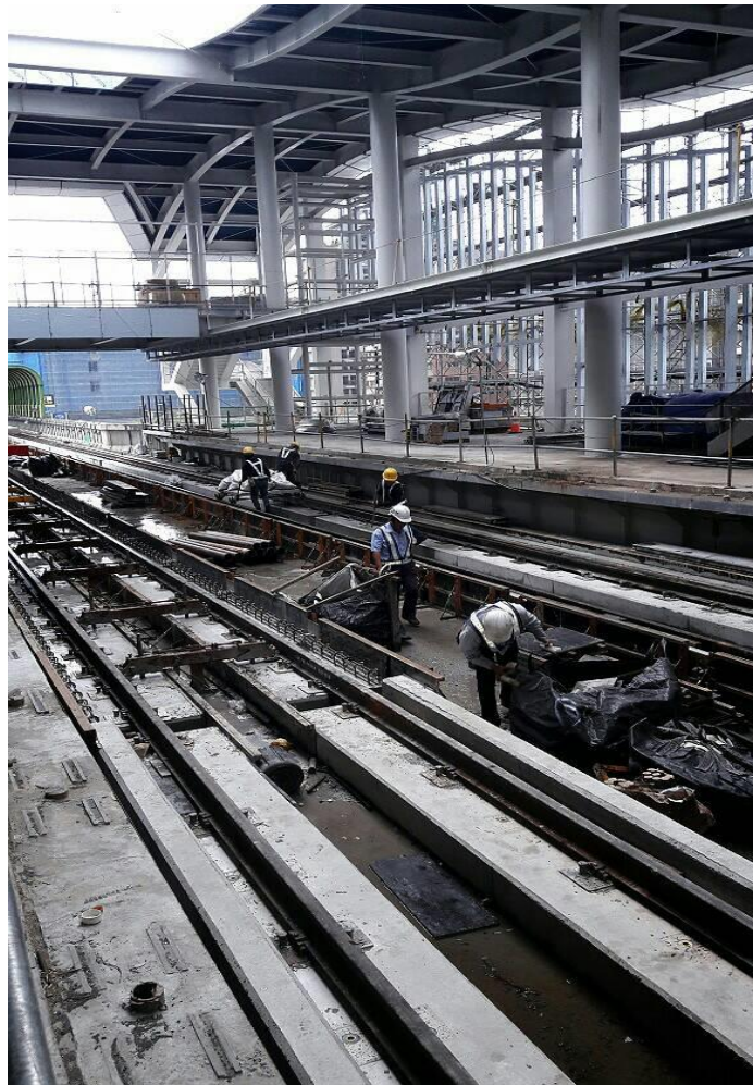
圖 6 車站區軌道施作現況
