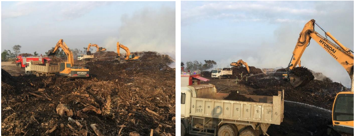
圖五 動員挖土機及卡車清運火警區樹枝。
