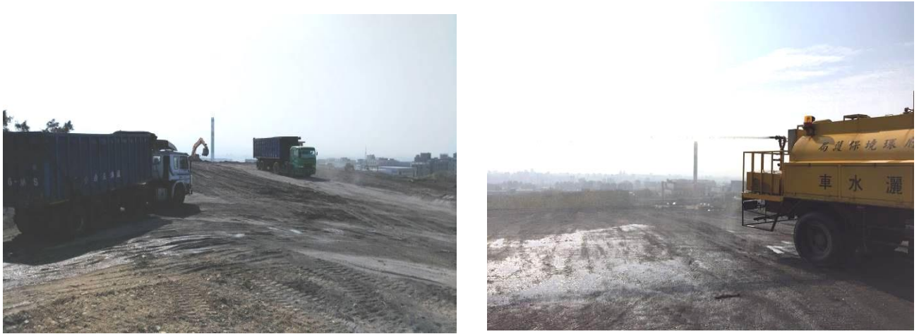
圖七 表層阻氧覆蓋(底渣資源化產品)與防塵灑水
