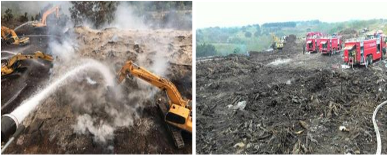
圖三 現場全力滅火作業
