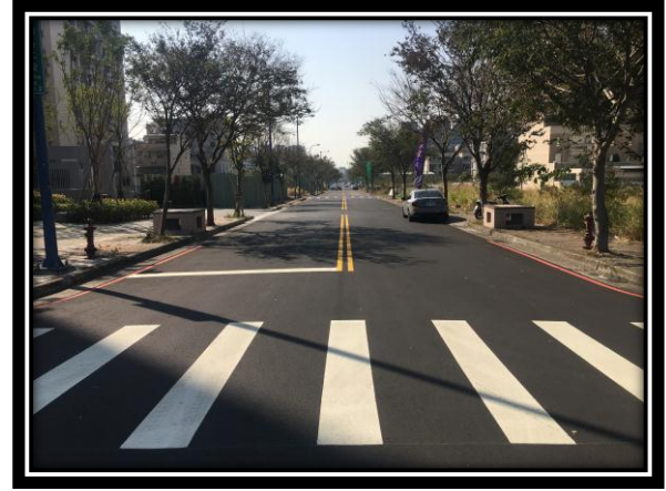
污水用戶接管完成後路面重新封層
