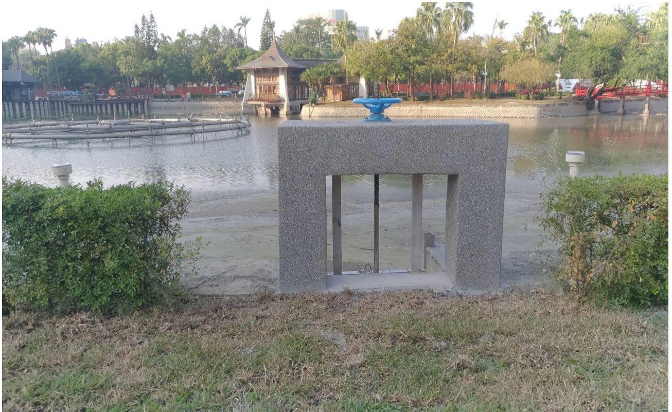
臺中公園日月湖放流閘門現況照
