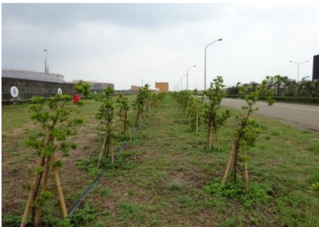
臺中火力發電廠
