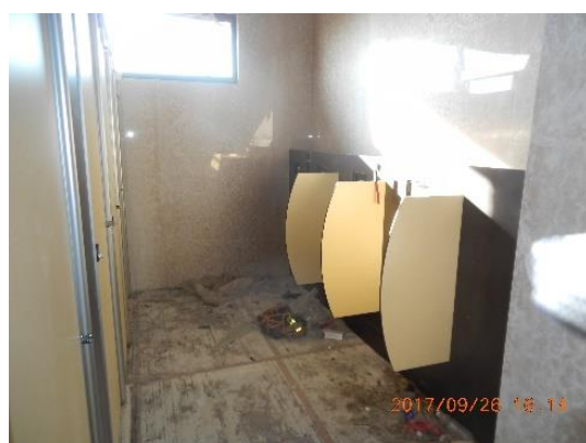
廁所相關設施施作
