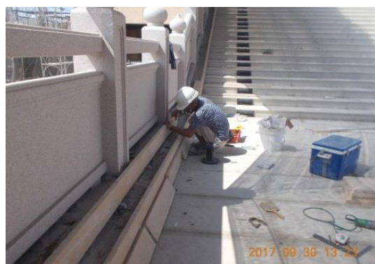
外牆欄杆基座石材施作鋪貼
