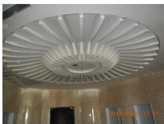
天花板裝設完成
