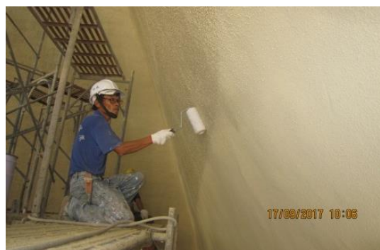
造型牆 GRC 上版內側耐候塗料施工
