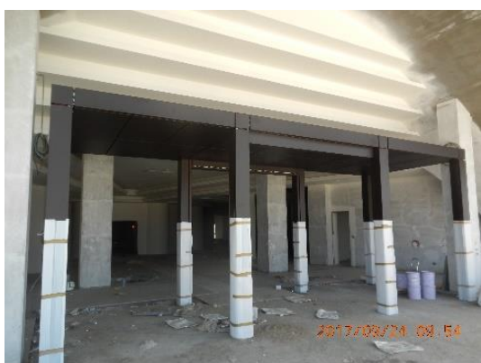
2F 除風室入口
