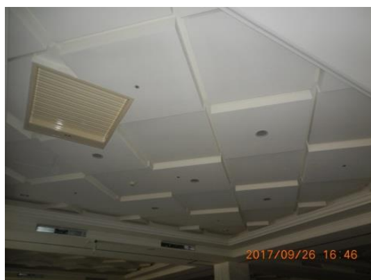
天花板裝設完成
