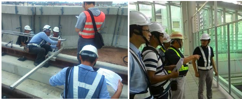
圖三 捷運軌道鋪設之跟班作業與站體結構安全視察
