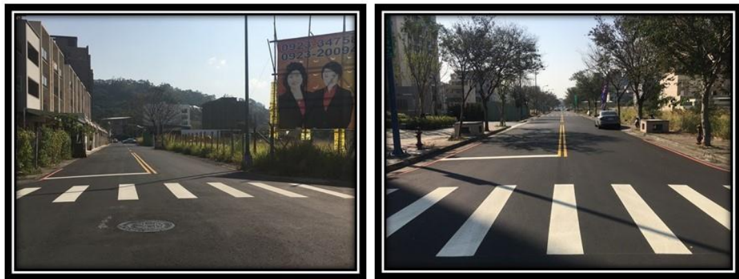
污水用戶接管完成後路面重新封層
