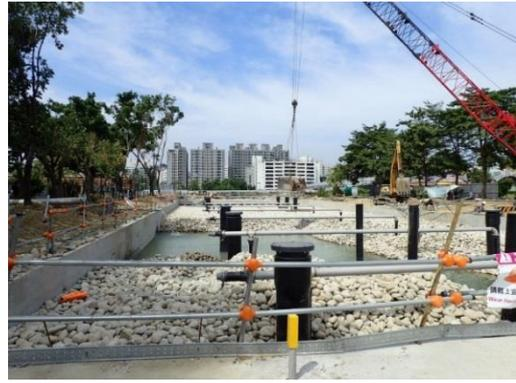
圖 24.礫石鋪設作業
