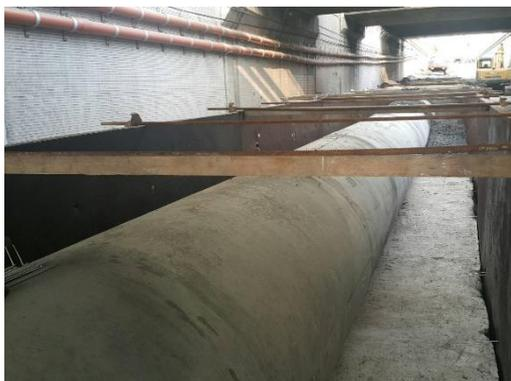
圖 15.引流管埋設
