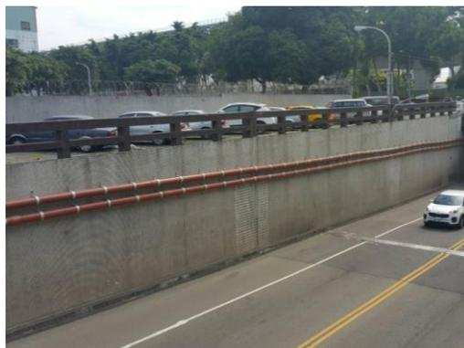
圖 16.地下道內臨時抽排 PVC 管
