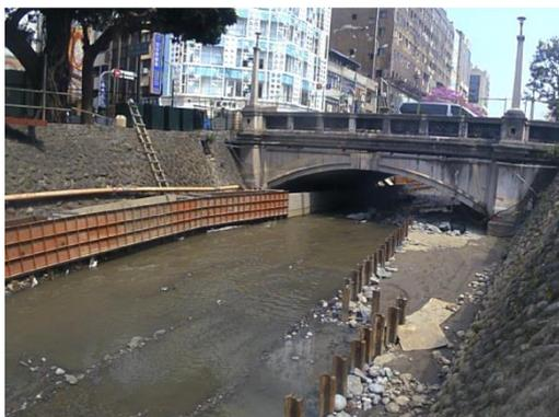
圖 30.中山綠橋下擋土牆完工
