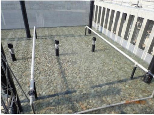
圖 23.礫間設施曝氣作業測試
