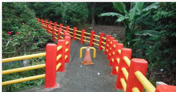
石岡里自行車道護欄改善
