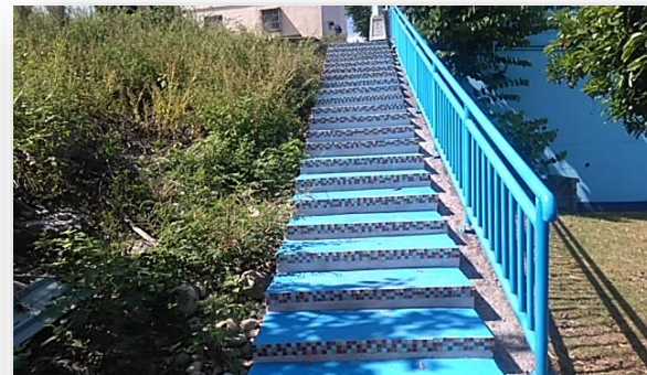
綠色走廊旁階梯改善
