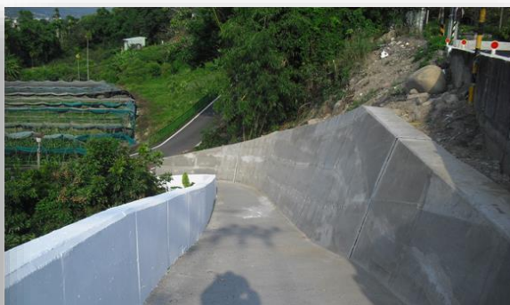
石城街新設護欄擋土牆
