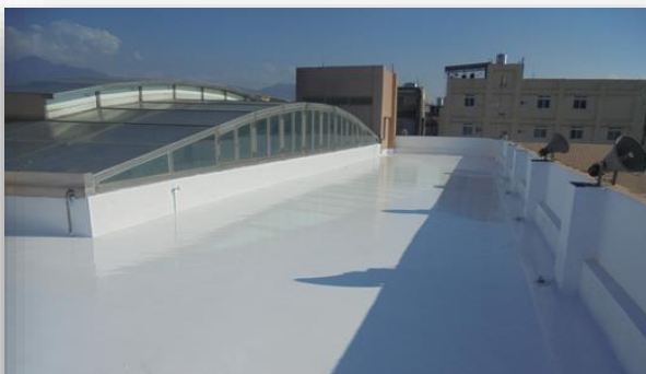
社福館屋頂防水隔熱改善
