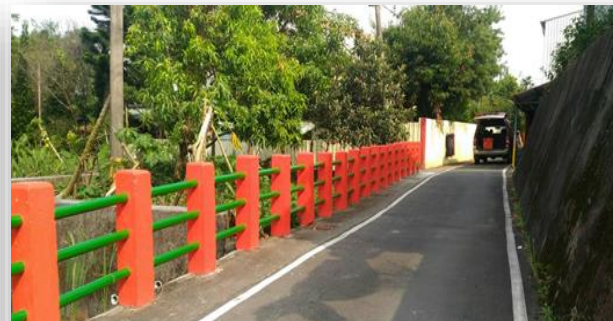
九房里復興巷欄杆油漆
