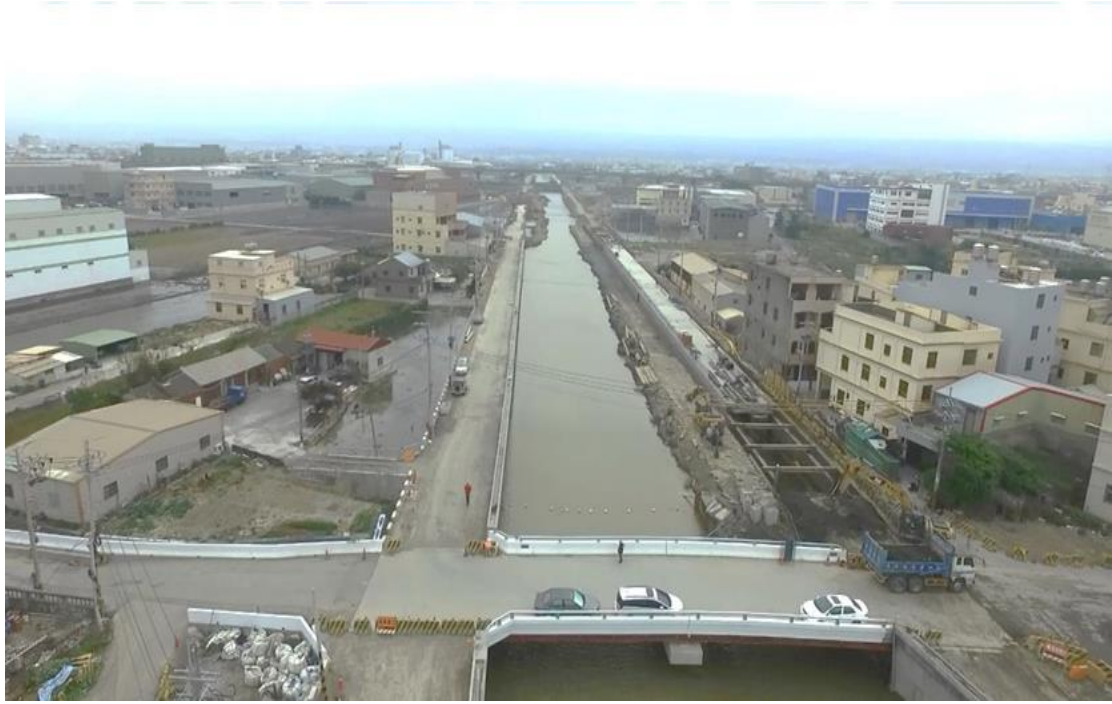
圖 4.南山截水溝施工照片
