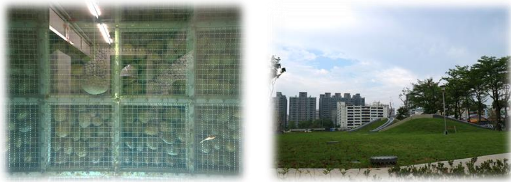
圖 16. 礫間處理設施現場照片
