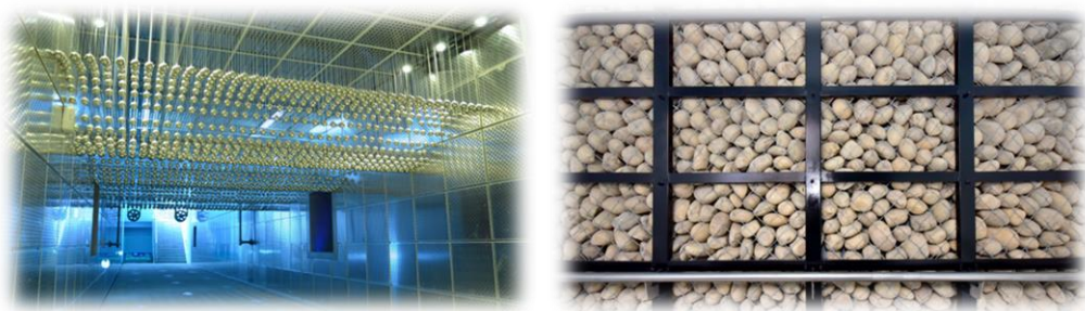
圖 9.地下礫間水質淨化處理現場照片
