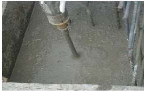
照片 3.14 振動棒使用及拔初時，應儘量維持垂直方向
