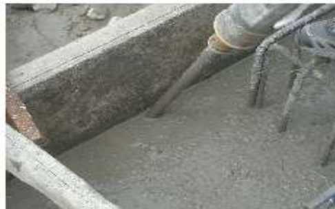
照片 3.15 振動棒不可傾斜且不可觸碰或振動模板
