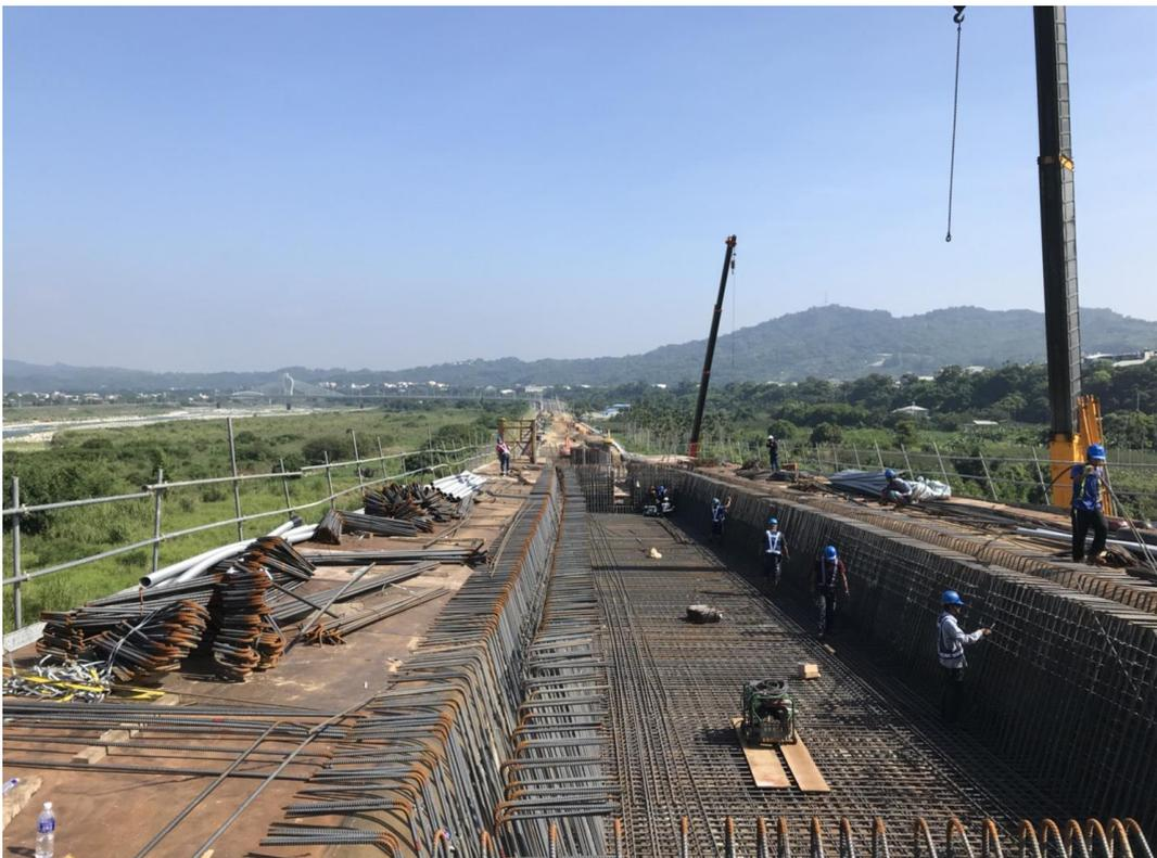
圖 2-12 第 5 標 5U1 預力箱型樑底腹板鋼筋綁紮
