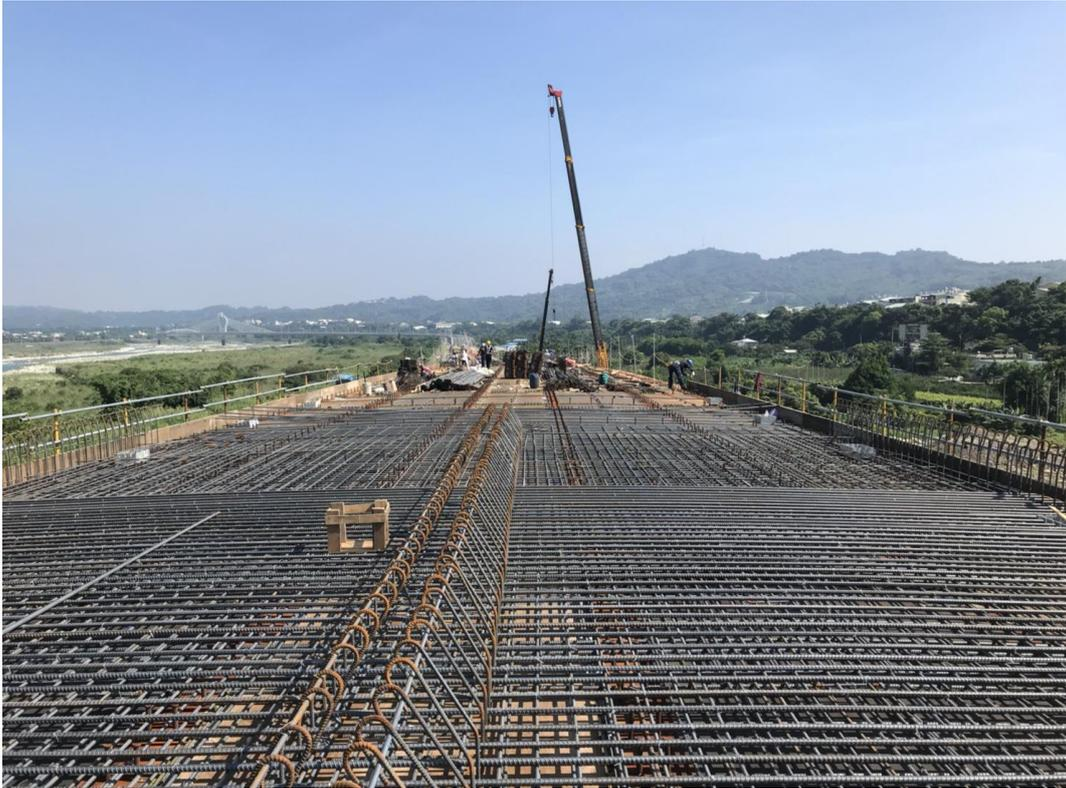
圖 2-11 第 5 標 5U2 橋面板鋼筋綁紮
