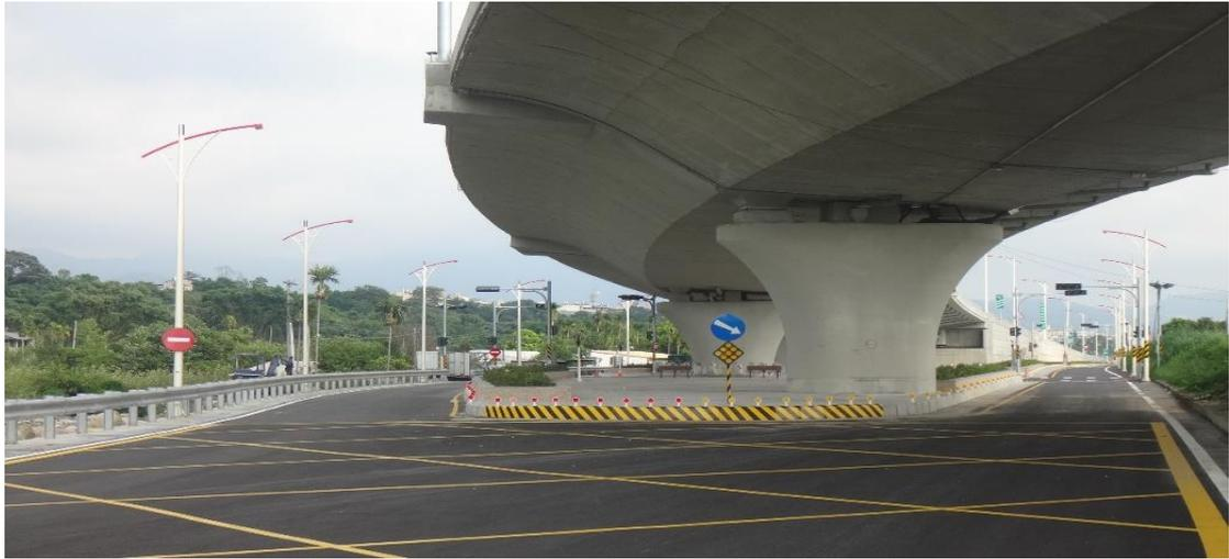
圖 2-9 第 4 標側車道及橋下空間完工照片
