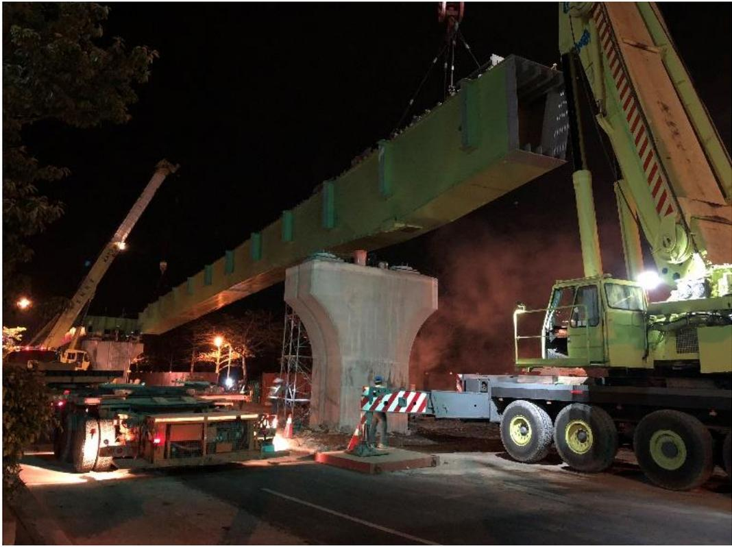
圖 2-13 第 5 標夜間吊裝鋼箱梁、降低交通衝擊
