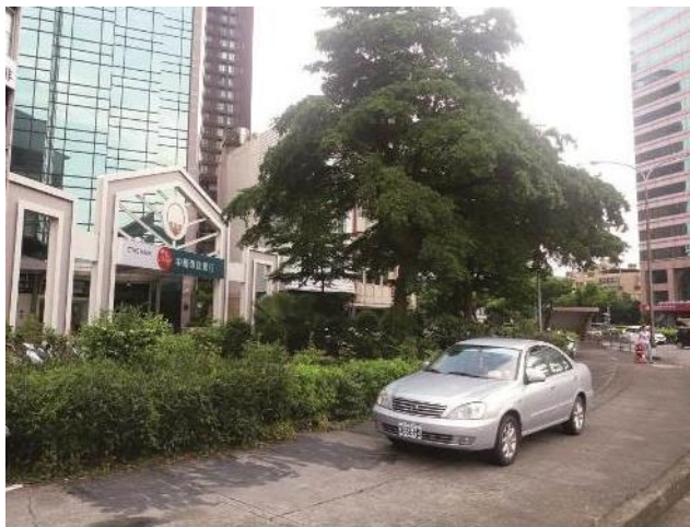
圖 5-18 忠明地下道周邊照片(東北角側)
