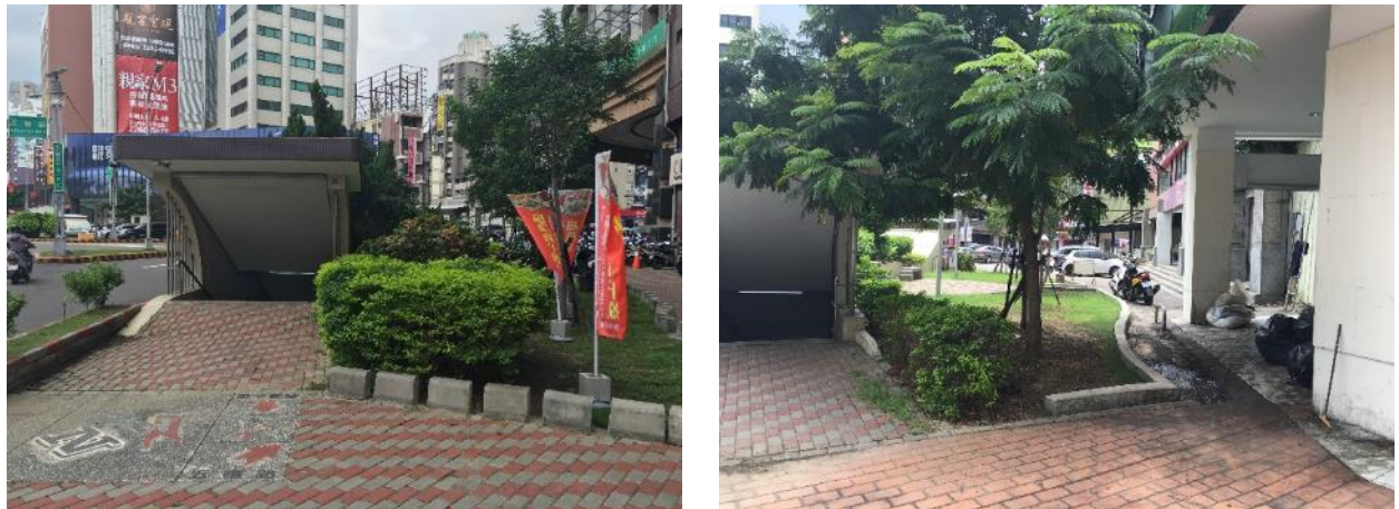
圖 5-5 五權地下道出入口現況
