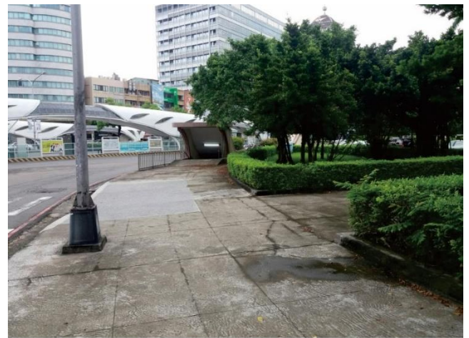
圖 5-19 忠明地下道周邊照片(忠明國小側)
