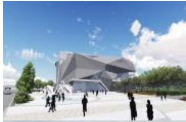
臺中市海洋生態館
