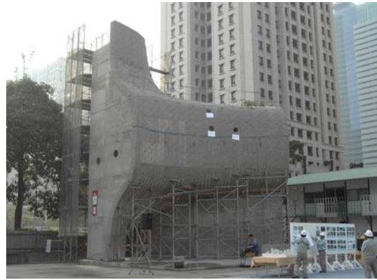
曲牆實體試作模型成果(結構體完成部分)
