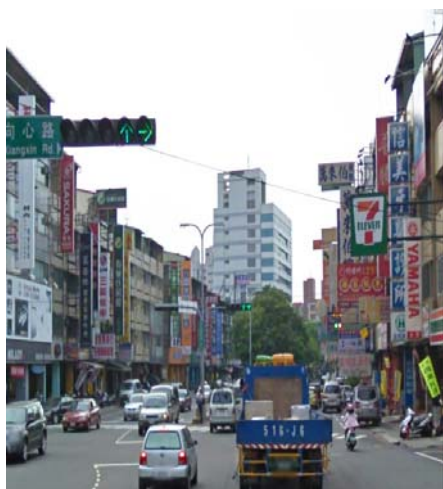
五權西路二段與向心路交叉路口整頓前
