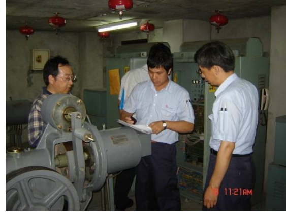
升降設備滑距安檢情形
