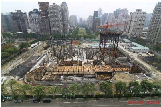
現場施工概況
