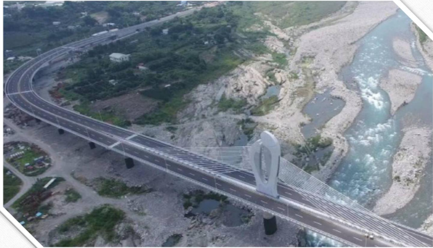
東豐快速道路 第4、第5標已完工
