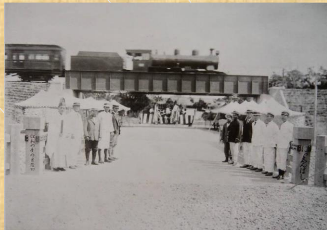
日治時期民生路鐵路陸橋
