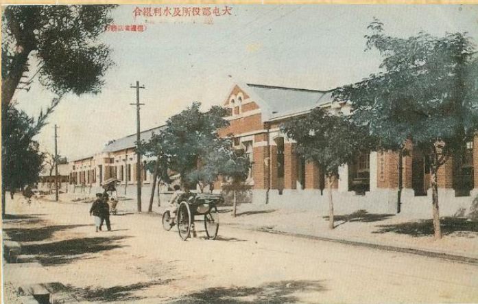
日治時期大屯郡役所及大屯水利組合事務所
