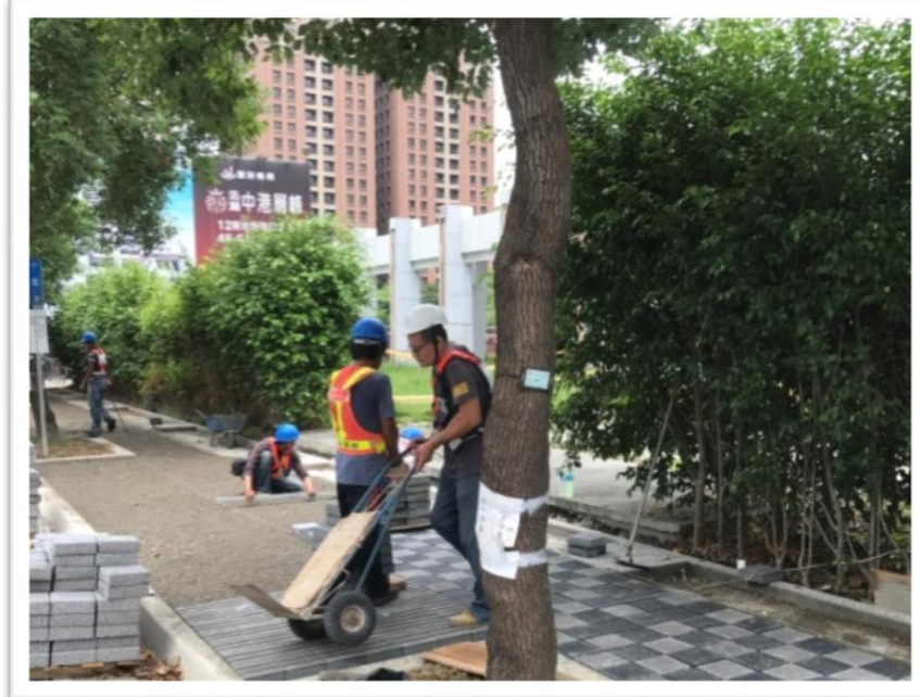
透水步道施工照片
